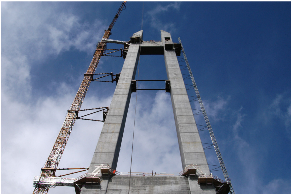
Figur 3.1: Brutårn under bygging. Foto: Statens Vegvesen. (4)
