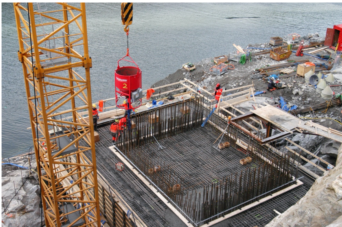
Figur 2.2: Bygging av brutårn til Hardangerbrua. Foto: Statens Vegvesen. (4)
