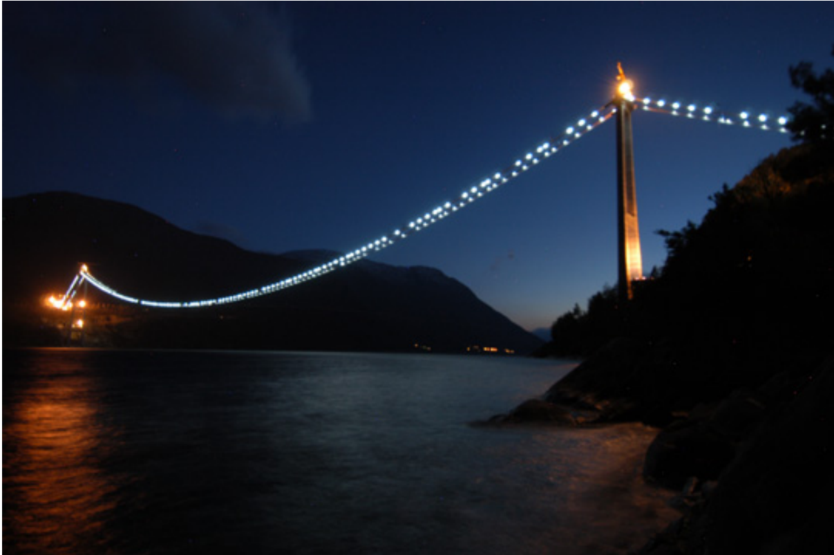
Figur 4.5: Lys på Hardangerbrua under bygging. Foto: Statens Vegvesen. (4)
