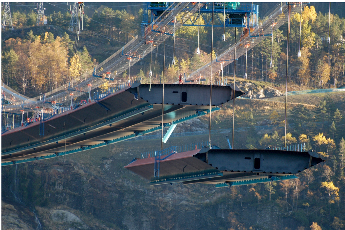
Figur 4.7: Montering av brukasse. Foto: Statens Vegvesen. (4)
