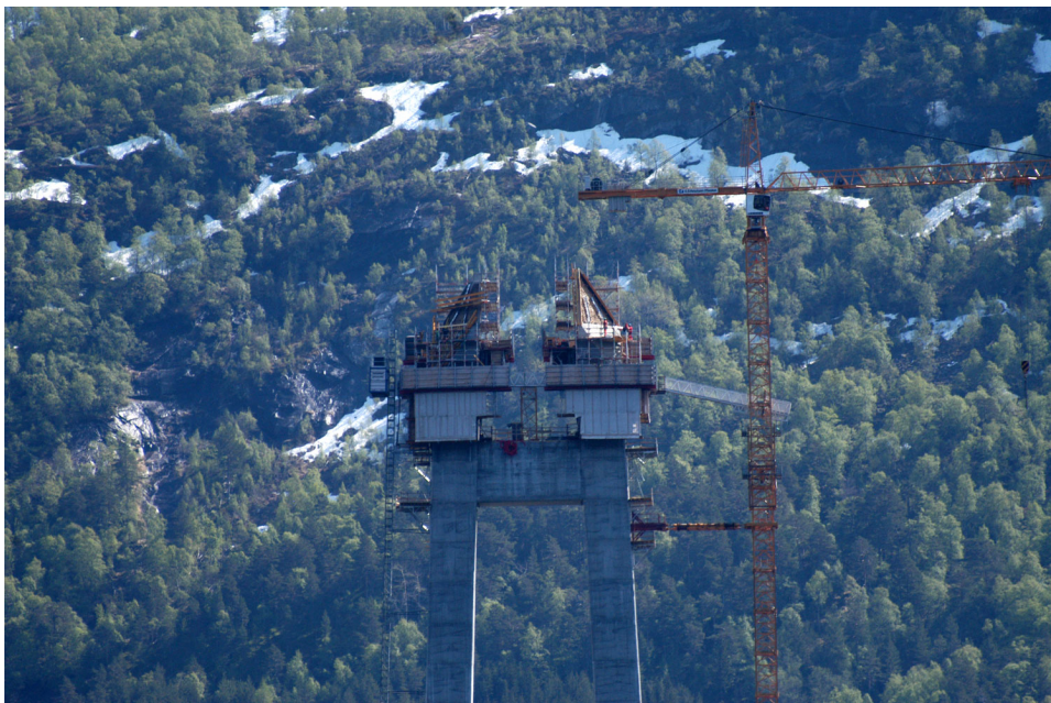
Figur 3.9: Tårntopp med forskaling og kran. Foto: Statens Vegvesen. (4)
