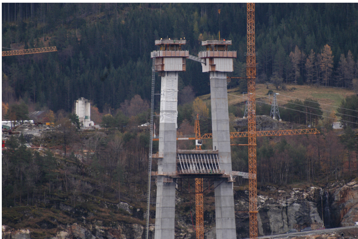
Figur 2.1: Brutårn til Hardangerbrua under bygging. Foto: Statens Vegvesen. (4)
