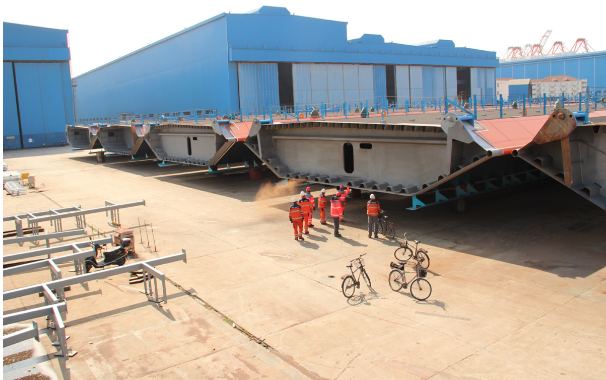
Figur 1.6: Avstivningsbærer under produksjon. Foto: Statens Vegvesen. (4)
