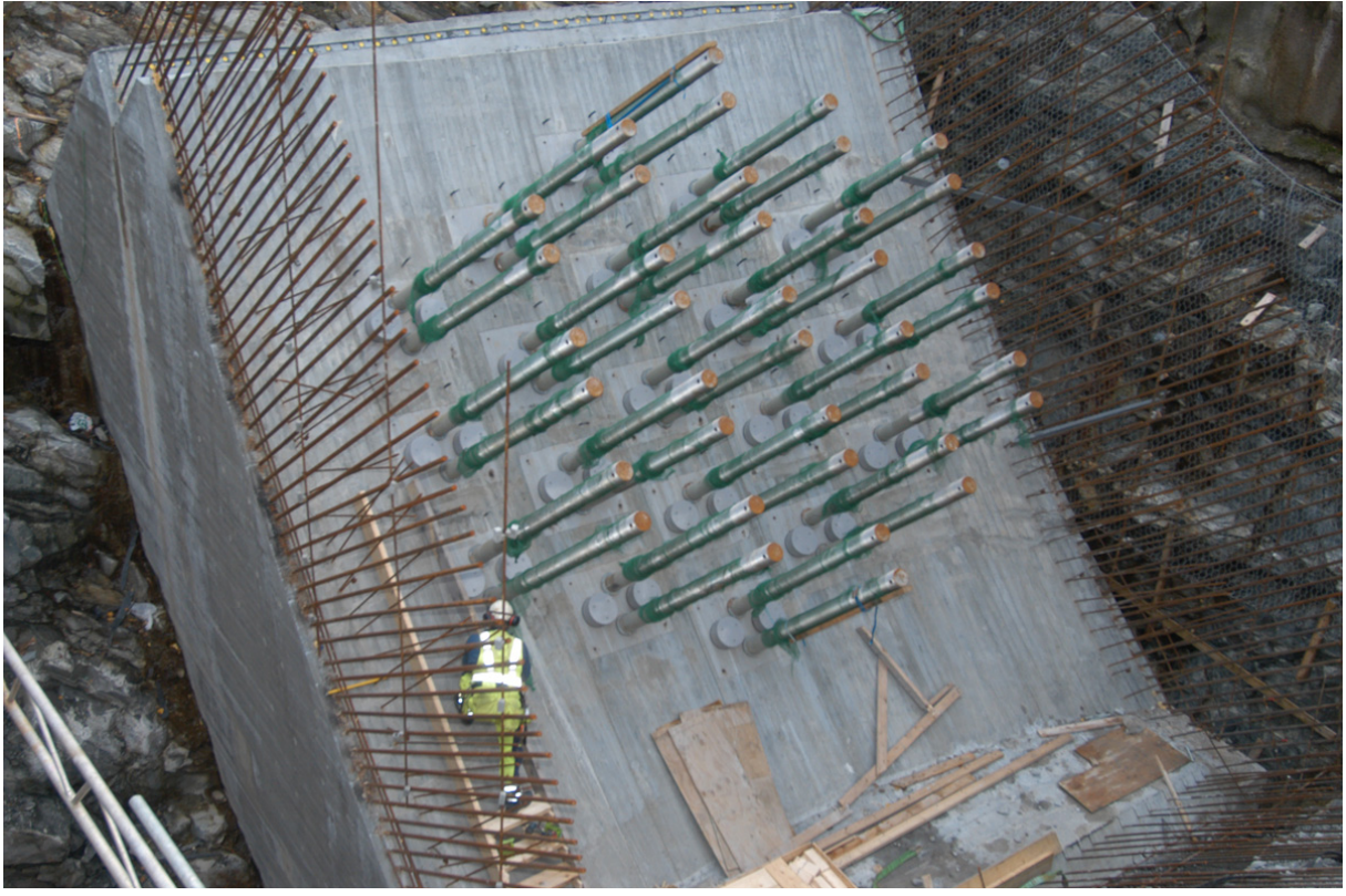
Figur 1.8: Forankringskloss under bygging. Foto: Statens Vegvesen. (4)
