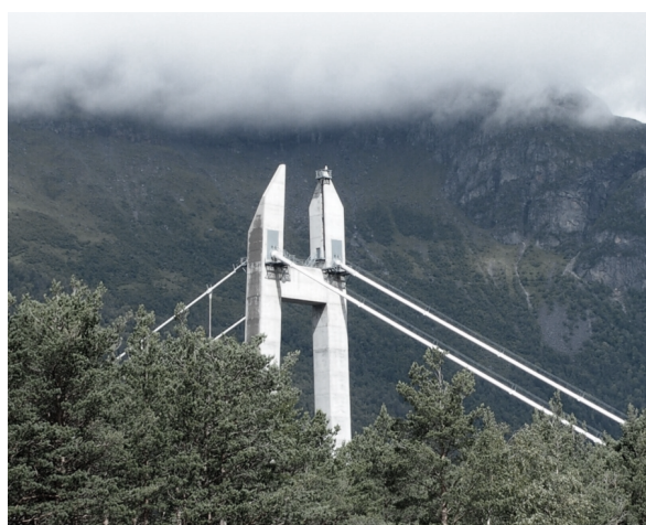
Figur 1.3: Bærekablens plassering på brutårnet [8]
