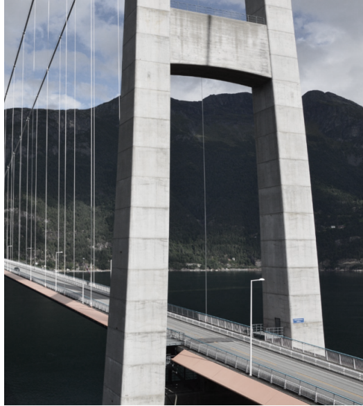
Figur 1.4: Avstivningsbæreren passerer mellom tårnbeina [9]
