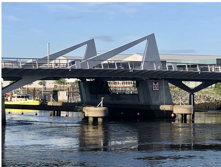
Figur 5.4: Detaljfotografi av fundamenter i farled under Pirbrua i Trondheim.
