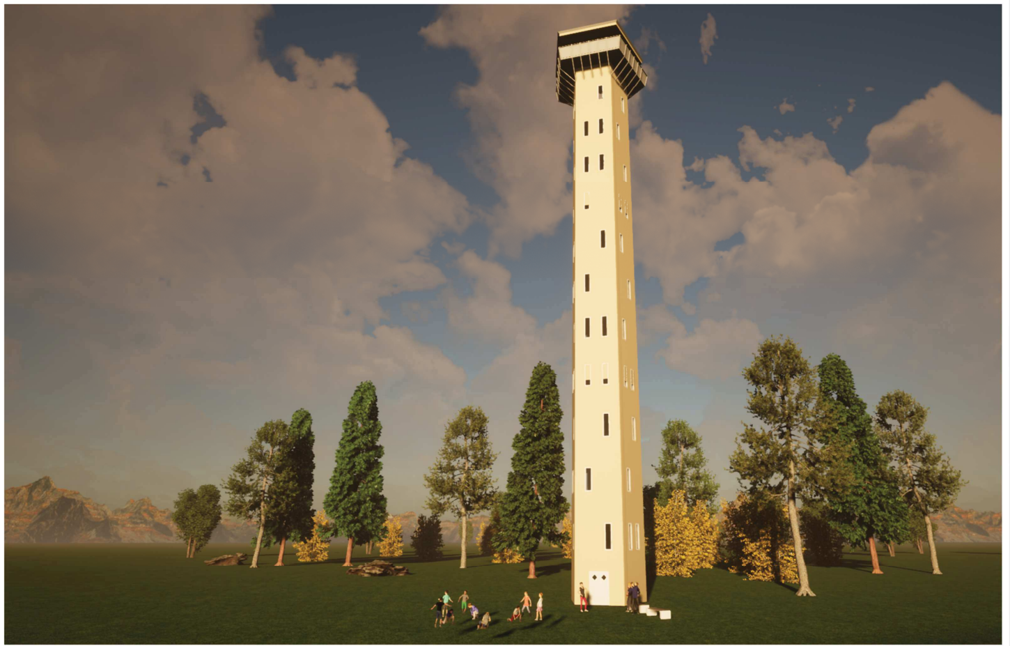
Tårnkonstruksjonen illustrert ved Atnsjøen, Stor-Elvdal
