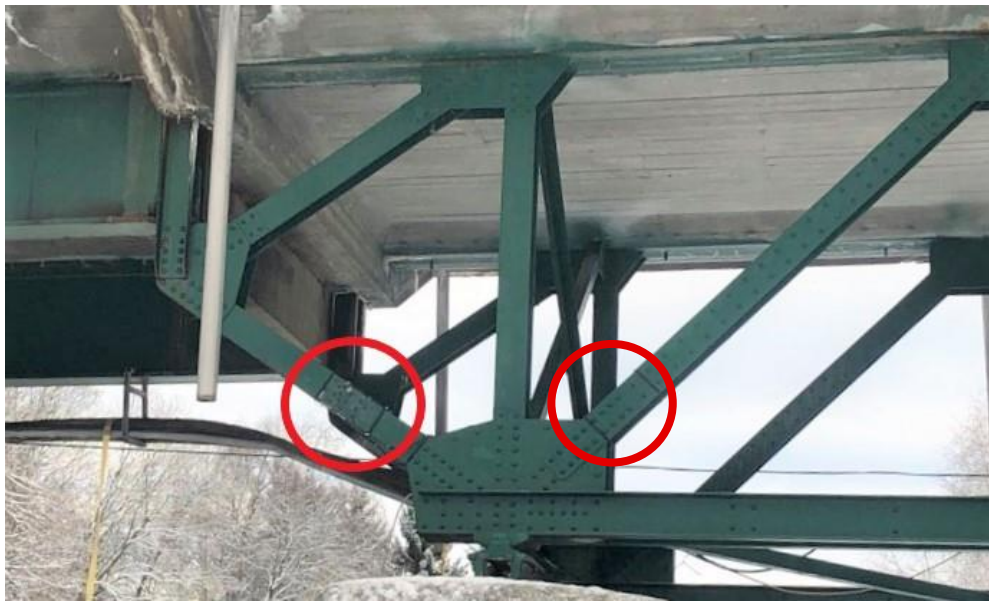
Figur 43: Foto viser den østlige siden av det nordlige fagverket og hvor overvåkingsutstyret som er montert
