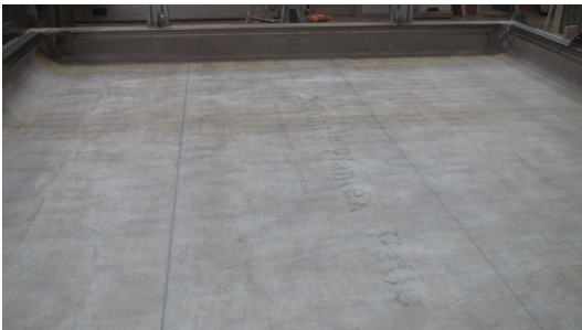
Figur 66: 4 mm gap med fiberduk over
