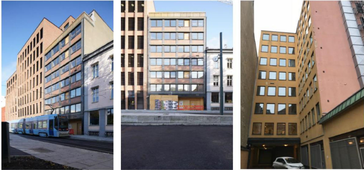
Figur 4.3: Kristian August gate 13 - eksisterende bygningsmasse (Elverum, 2020).
