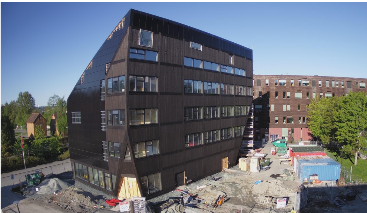
Figur 12: ZEB-laboratoriet sett fra nordøst 01.06.20. Bildet er tatt med kamera fra byggekamera.no
