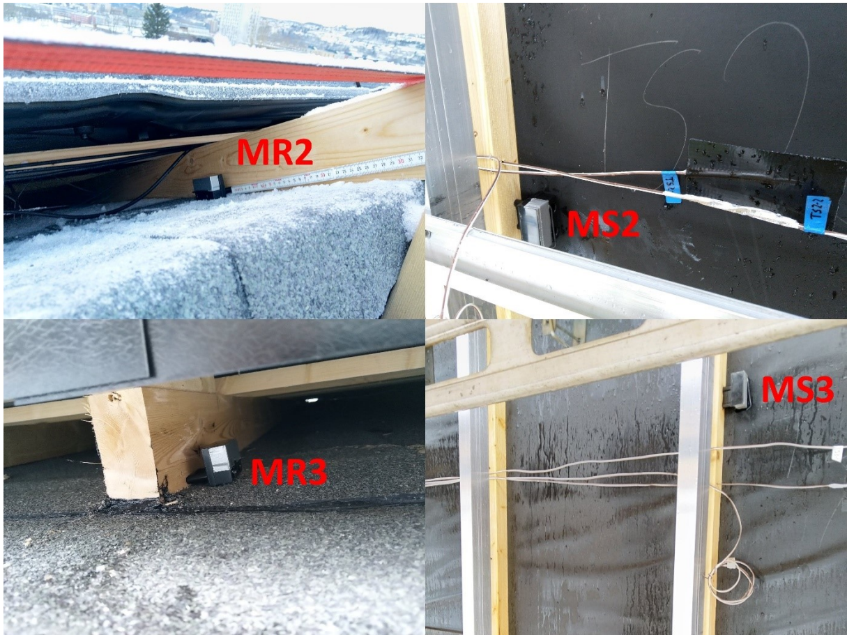
Figur 21: Sensorbilder fra taket og sørfasaden. Foto: Undertegnede, desember 2019 og februar 2020
