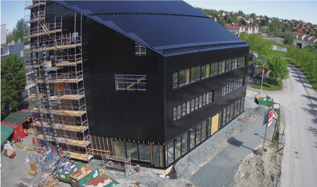
Figur 11: ZEB-laboratoriet sett fra sørvest 01.06.20. Bildet er tatt med kamera fra byggekamera.no.
