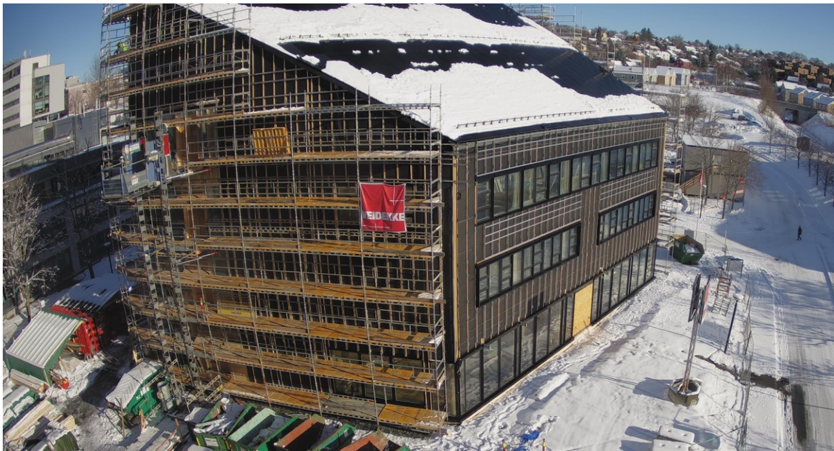
Figur 25: ZEB-laboratoriet sett fra sørvest 25.02.20. Bildet er tatt med kamera fra byggekamera.no.
