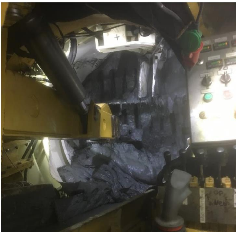
Figur 55: Bløte masser ved rørfronten i prosjektet på Sluppen (A. Watn, personlig kommunikasjon, 19.10.2019)
