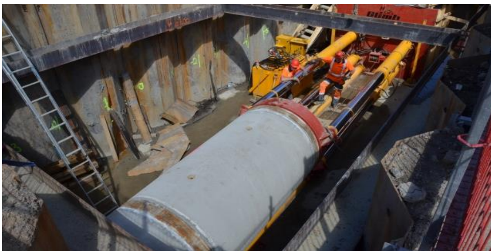
Figur 2: Pressgrop. Rør presses inn vha. hydrauliske sylindere (Myhre og Olimb, 2015).
