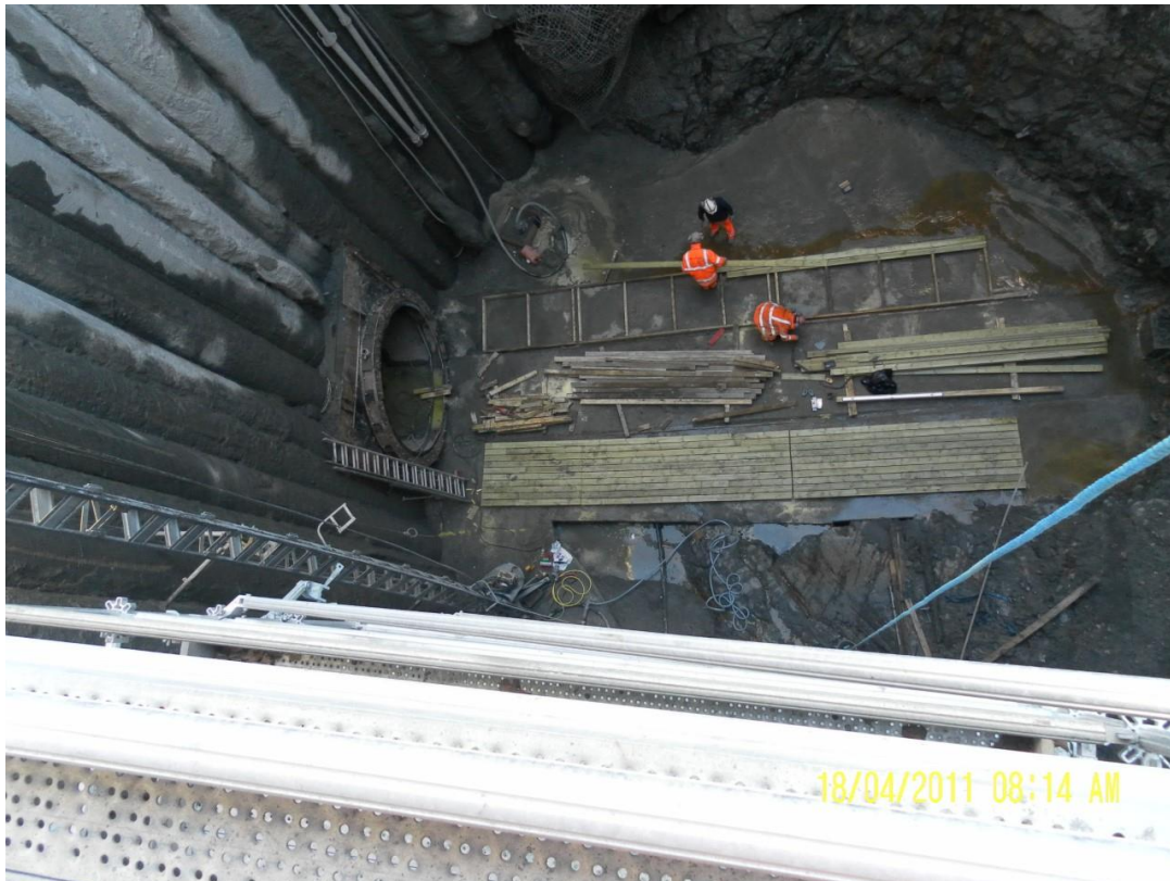
Figur 7: Pressgrop avstivet med jetinjisering ved prosjektet Midgardssormen i Oslo (A. Valle, tidligere prosjektleder i Olimb, personlig kommunikasjon, 02.10.2019)
