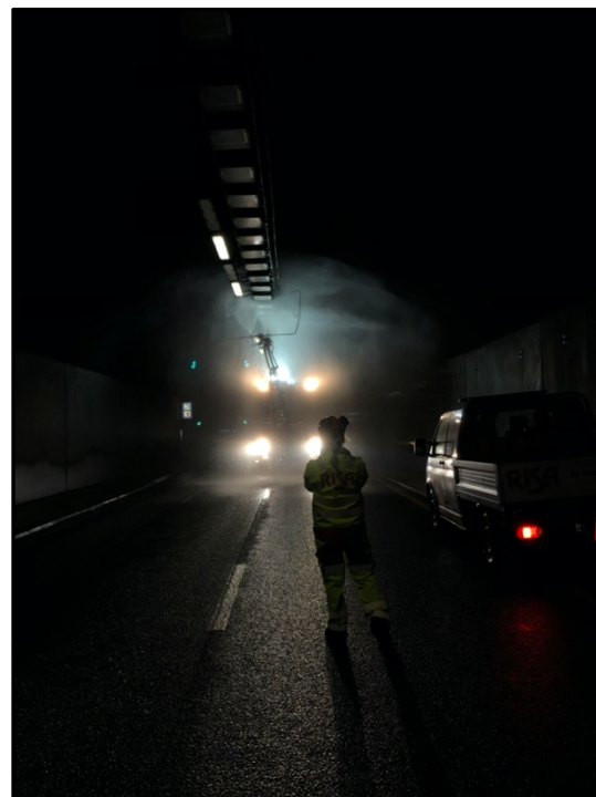
Figur 7: Utførelse av vasking i tunnelene
