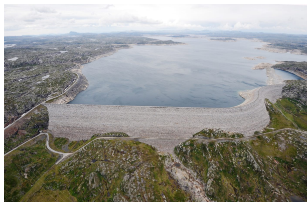
Figur 1: Venstre: Paulenfoss, statens første kraftverk fra 1895 [69]. Høyre: Oddatjørn-dammen, høyeste fyllingsdamkonstruksjonen i Norge som ble ferdigstilt i 1988 [42].
