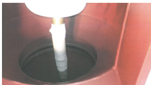
(b) Reparert løsning - Gjennomføring fase L2
