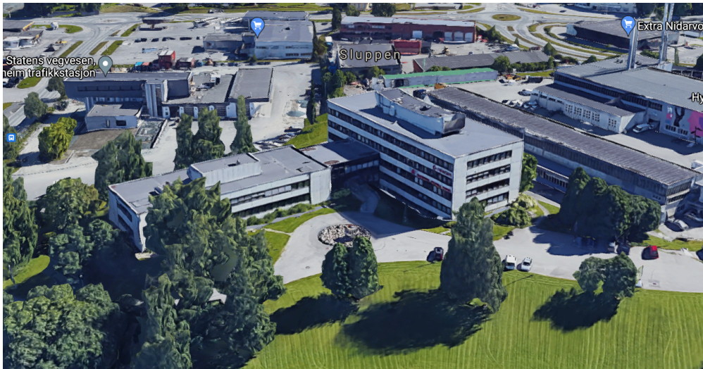
Figur 2.2: Kraftbygget med lavblokka til venstre og høyblokka til høyre i bildet [3]
