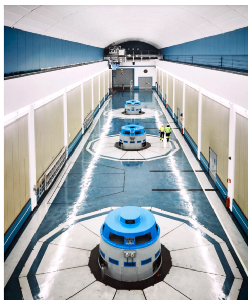
Bilde 2: Maskinsal i vannkraftverk
