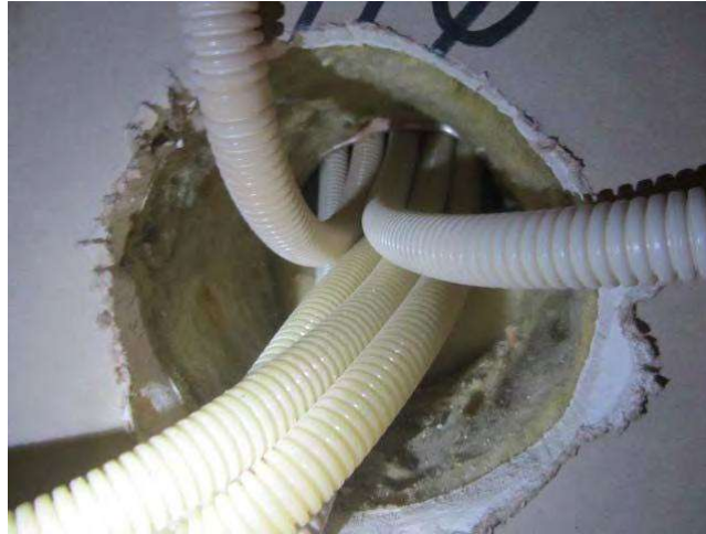
Figur 4. 2: Hull som ikke er tett i brannskille [23]
