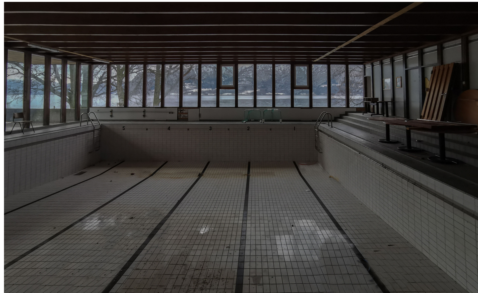
De eksponerte limtrebjelkene, sammen med stålsøyler og et par betong vegger, bærer hele taket.
