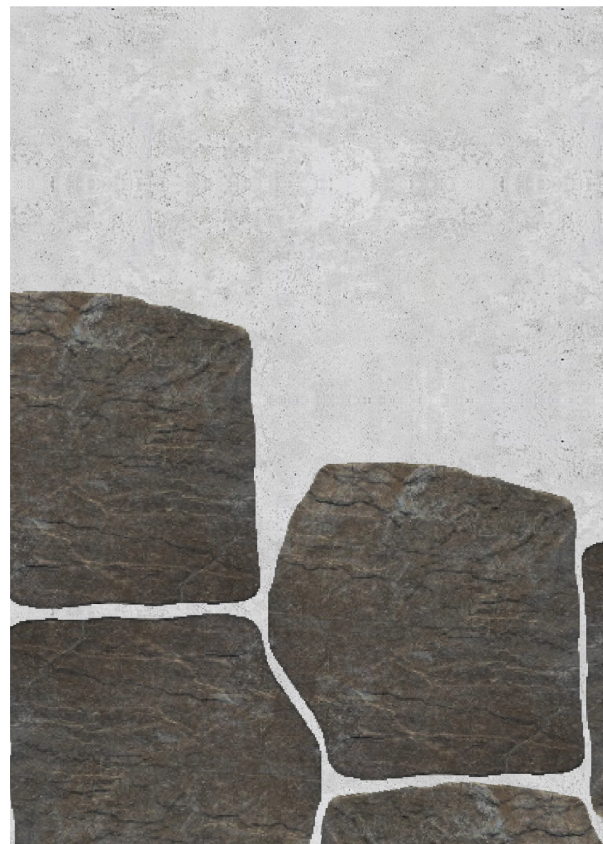
Møte mellom opprinnelig skifer og ny betong
