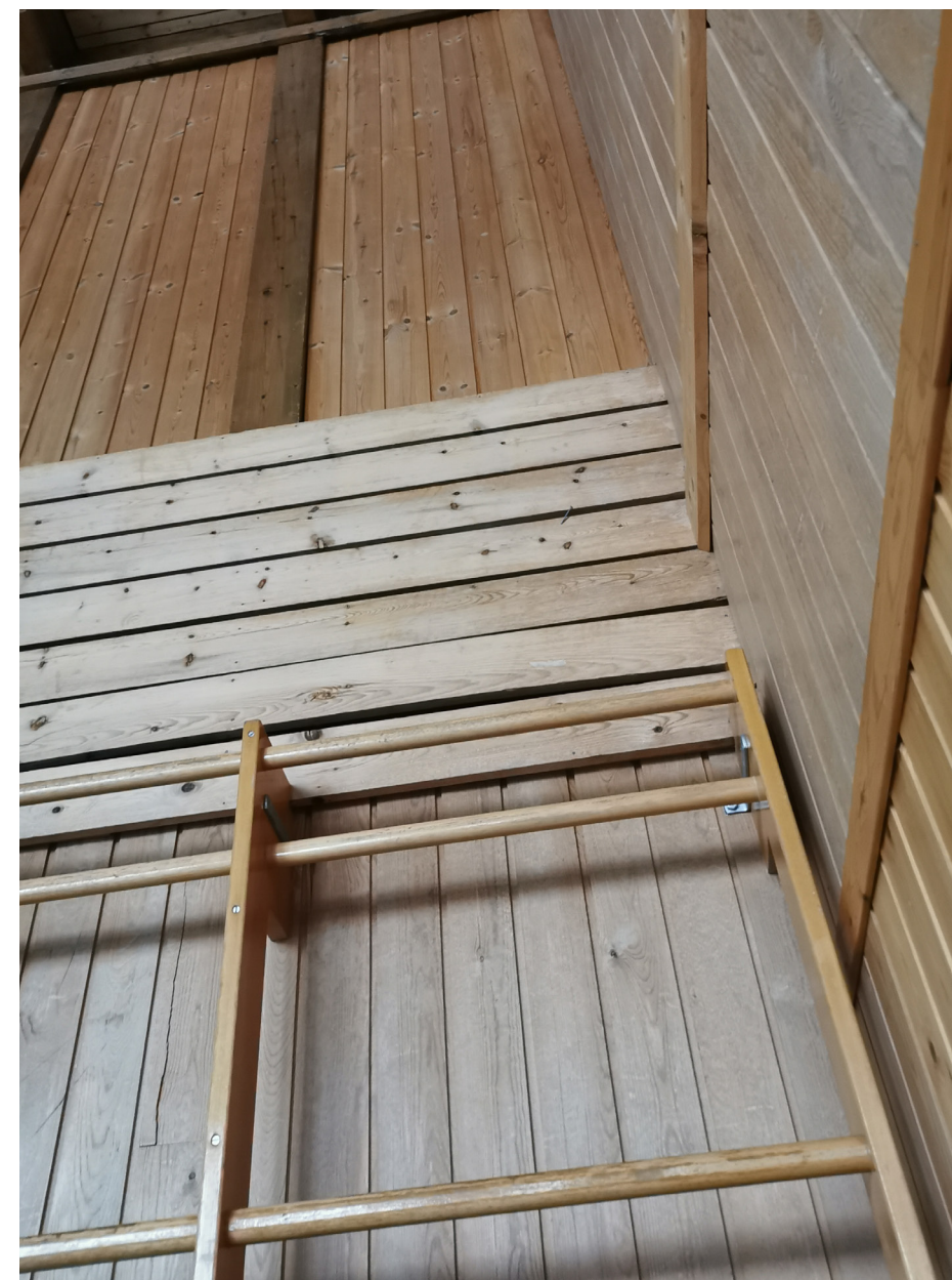
Veggene er kledd i trepanel. De øvre delene av veggene var opprinnelig åpne opp mot vestibylen, hvor det idag er bibliotek.
