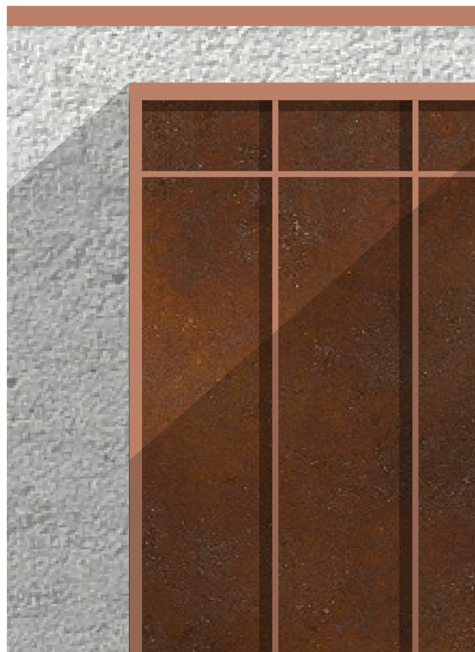
Kortenstål fasade, med trelister mot eksisterende råbetong
