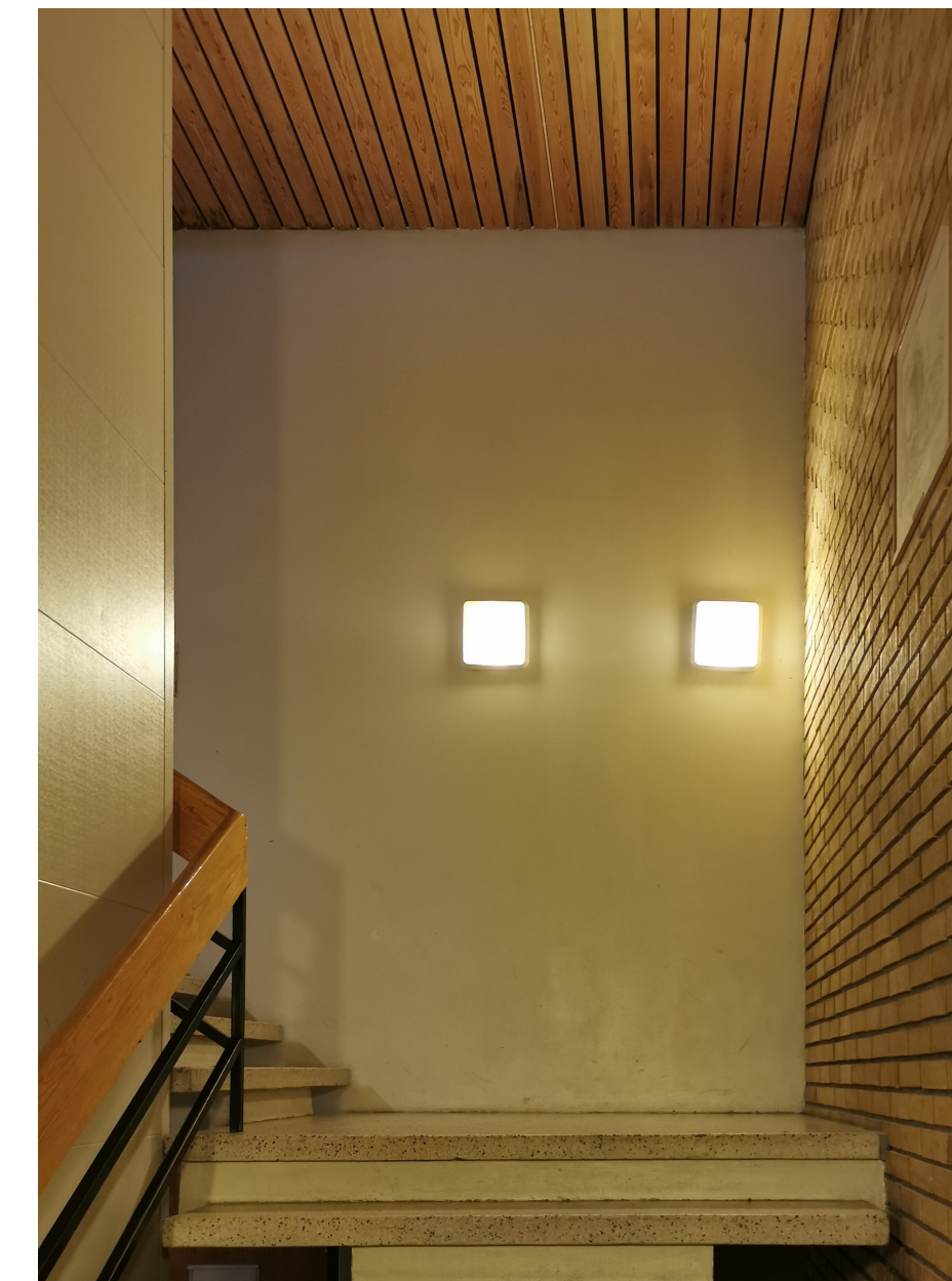
Der limtretragerne ikke er synlige er de kledd i en himling av trespiler av furu. Gulet eglsteinsvegger er brukt som fondvegger gjennomgående i alle tre skolebygg.
