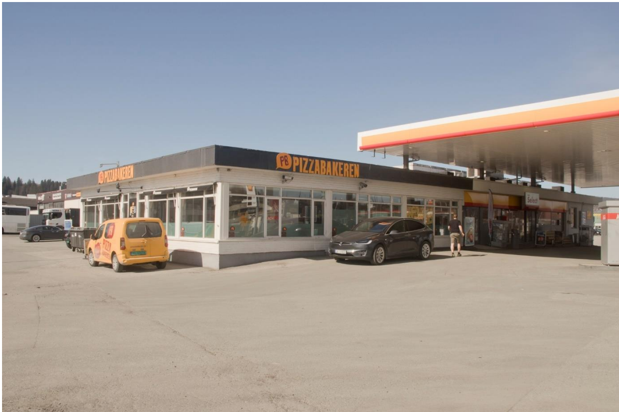
Bilde 14: Bensinstasjonen i Bratsbergvegen 17.
