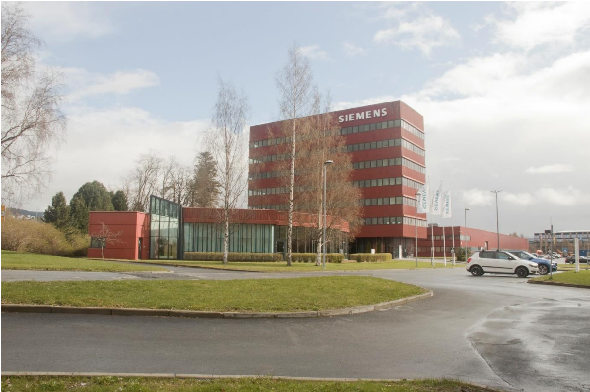
Bilde 8: Siemens-anlegget vest.
