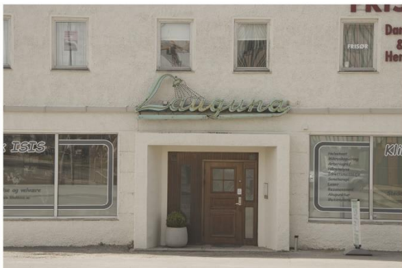
Tempevegen 21 VERNEVERDIER: 1, 2, 4,5, 6, 14. ANNET: Neonskilt
