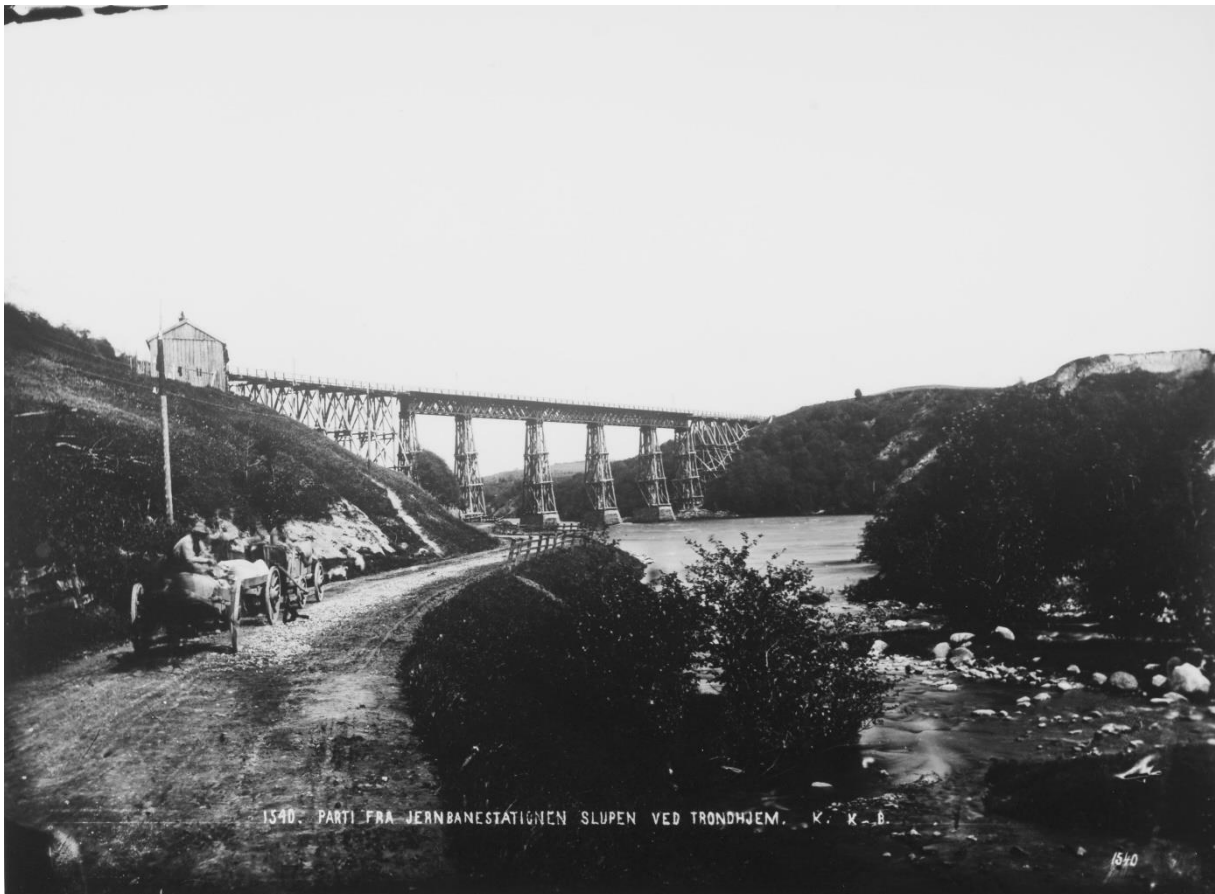
Bilde 2: Jernbanebrua på Sluppen fotografert mellom 1864-1884. Fotograf: Knud Knudsen, UBB. 15
