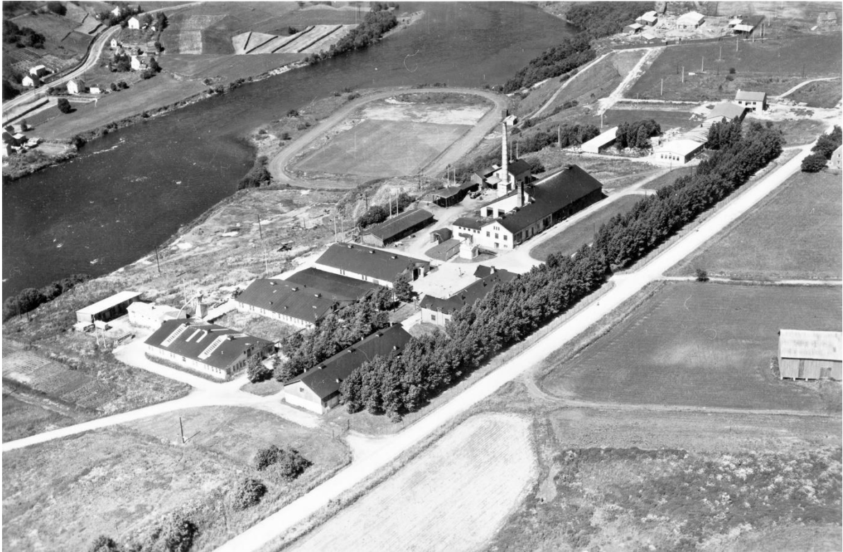
Bilde 3: Renholdsverkets anlegg på Sluppen i 1952. Fotograf: Vilhelm Skappel for Widerøes flyveselskap og Polarfly. Flyfoto: Tempe. 1952. 21
