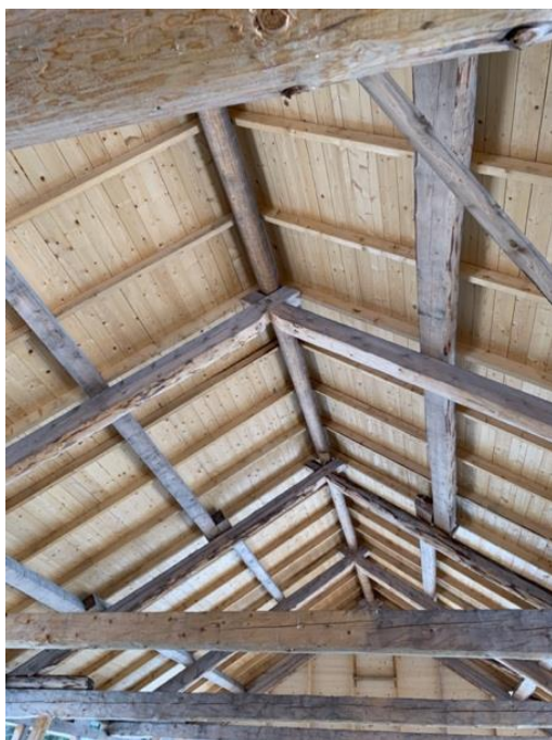
Figur 2: Takkonstruksjonen i nybygget. Foto: Ida Helene Skorge, januar 2020.
