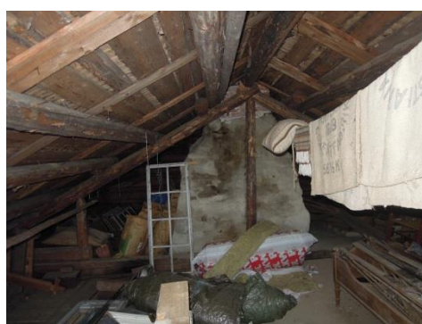
Figur 23: Takkonstruksjon med pipegjennomføring Foto: Svein Arne Rudi
