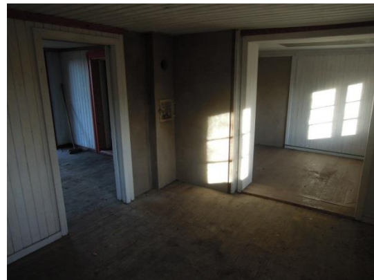
Figur 10: Innvendige rom er restaurert etter brann. Foto: Svein Arne Rudi
