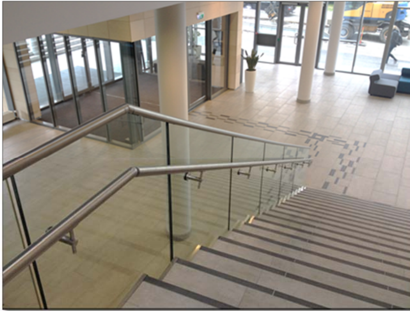
Figur 29: Bilde fra den nye Handelshøyskolen i Trondheim viser godkjent luminanskontrast på trappenesen og ledelinjer i gulv (Eget foto)
