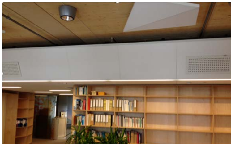
Figur 24: Ventilasjonskanaler danner vanskelig tilgjengelig samlingsplass for støv (Eget foto)
