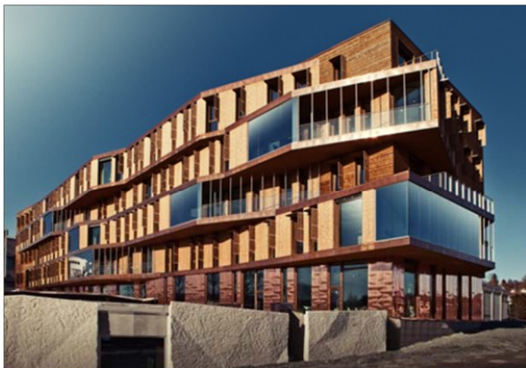
Figur 11: Sørvestvendt fasade og sokkel som en isbre (Foto: Pir II)
