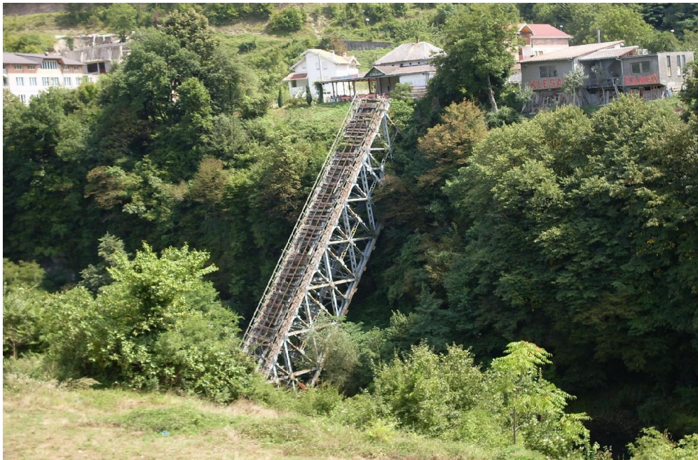
Jernbrua i Jablanica. 55
