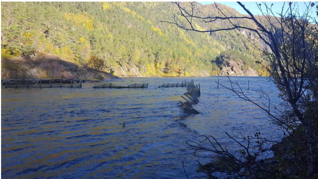
Bilde: Brudd i ledegjerdet etter flommen i september 2020.
