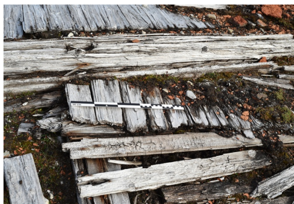
Figur 33: Obj. 11 - Rester av dobbelt plankegulv (TBA).
