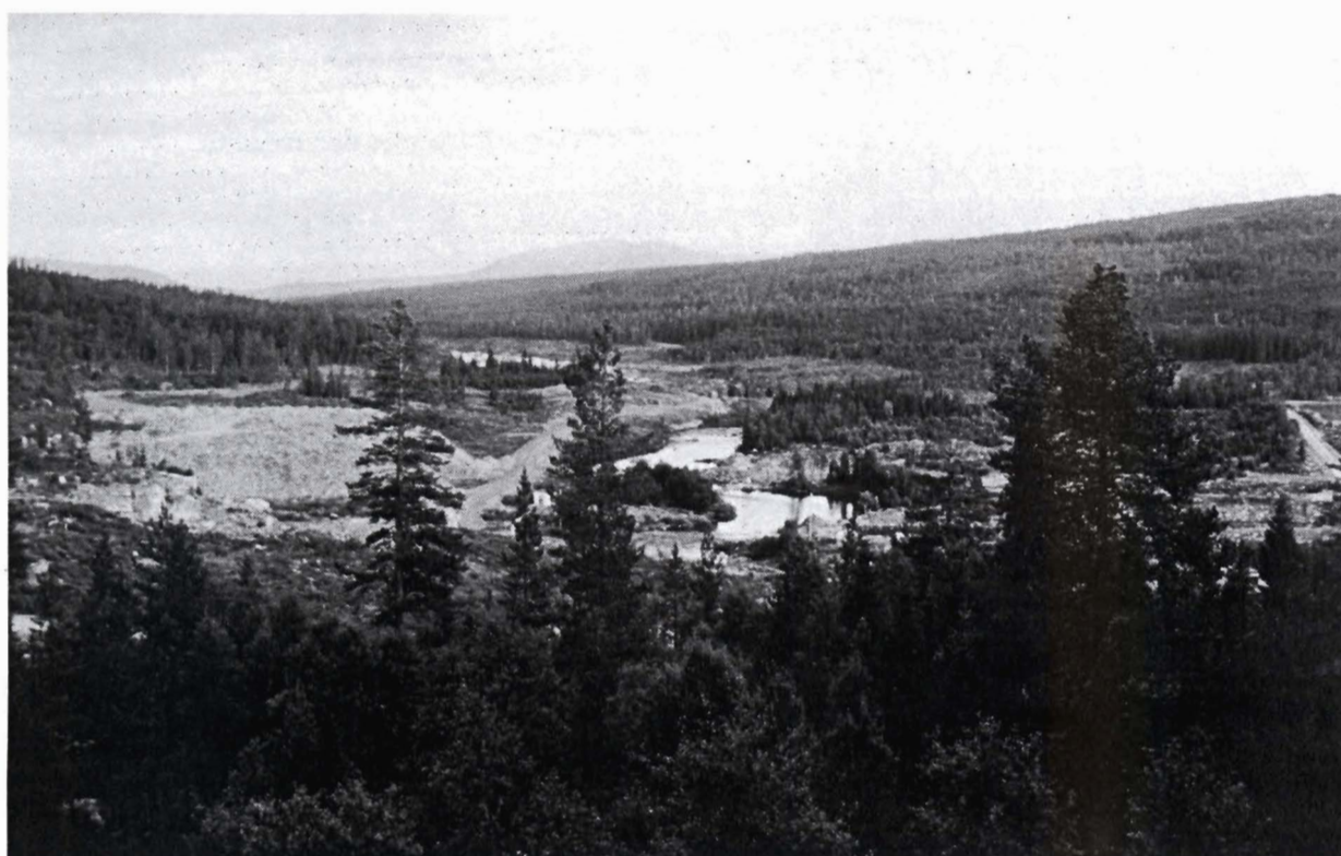
Figur 3. Området hvor Tevlamagasinet ble etablert i 1994. Øverste bilde er tatt før byggestart (sept 1990) og nederste bilde er tatt under byggeperioden (aug 1991). Foto: Jo Vegar Arnekleiv.
