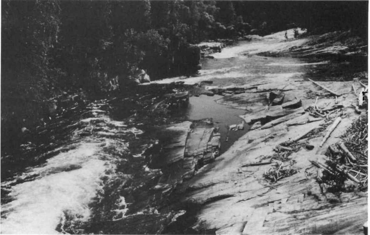
Figur 4. Hyttfossen er en skrå renne i berget. Sett nedstrøms.
