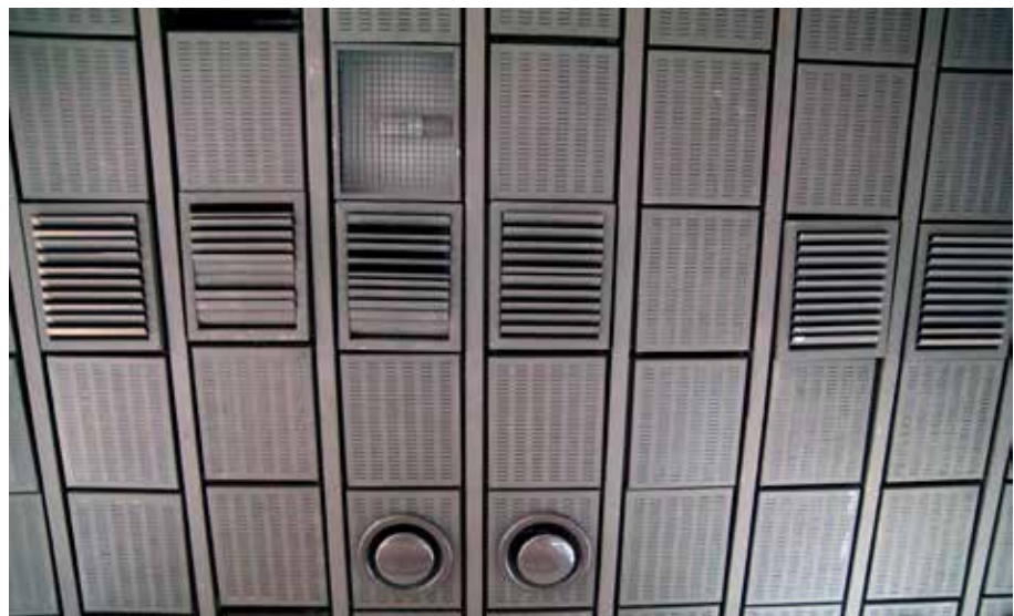
Øverst: himling i 2. etasje. Lampe og luftdyse. Nederst: Himling i utstillingsareal i 1. etasje. Integrert lampe, ventilasjonsdyser.
