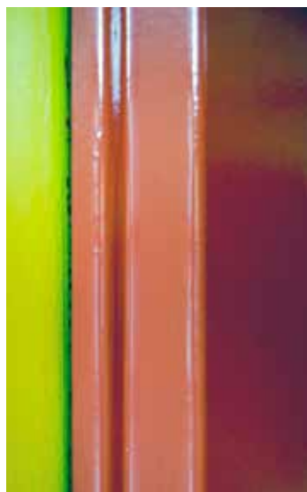
Inngangsdøra, vindfanget utenfra, himlingen, list på innerdør.
