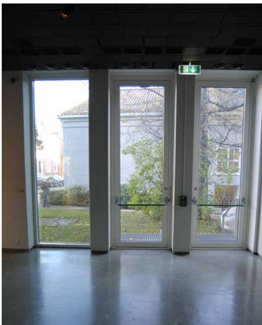
Vindu mot øst i hovedutstillingsrommet. De to rømningsdørene til høyre.
