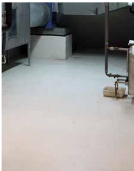
Takluke, malt betong, gulv.
