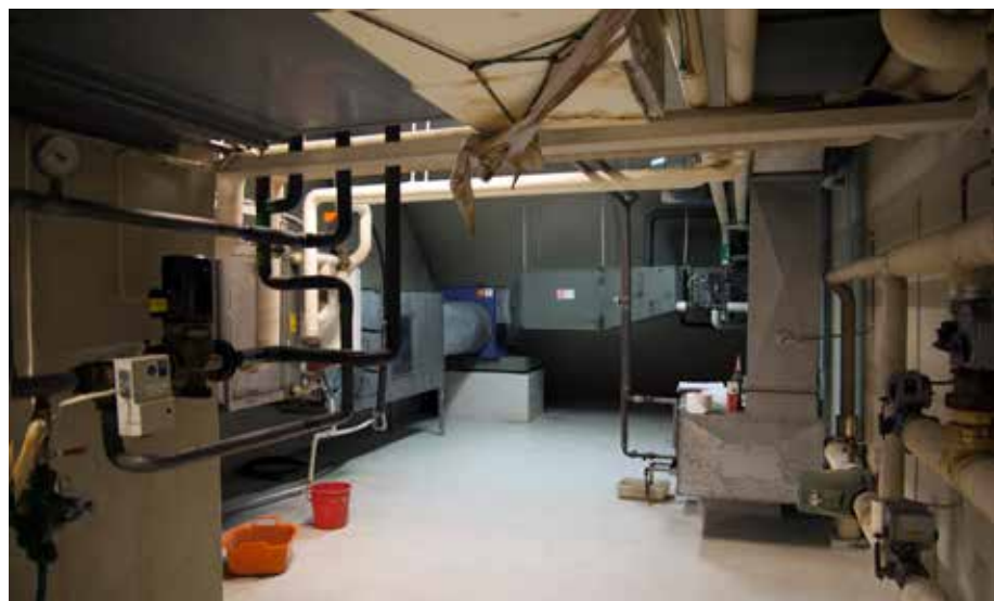
Ventilasjonsrom i øst, vindeltrapp, ventilasjons- rom i 4. etg.
