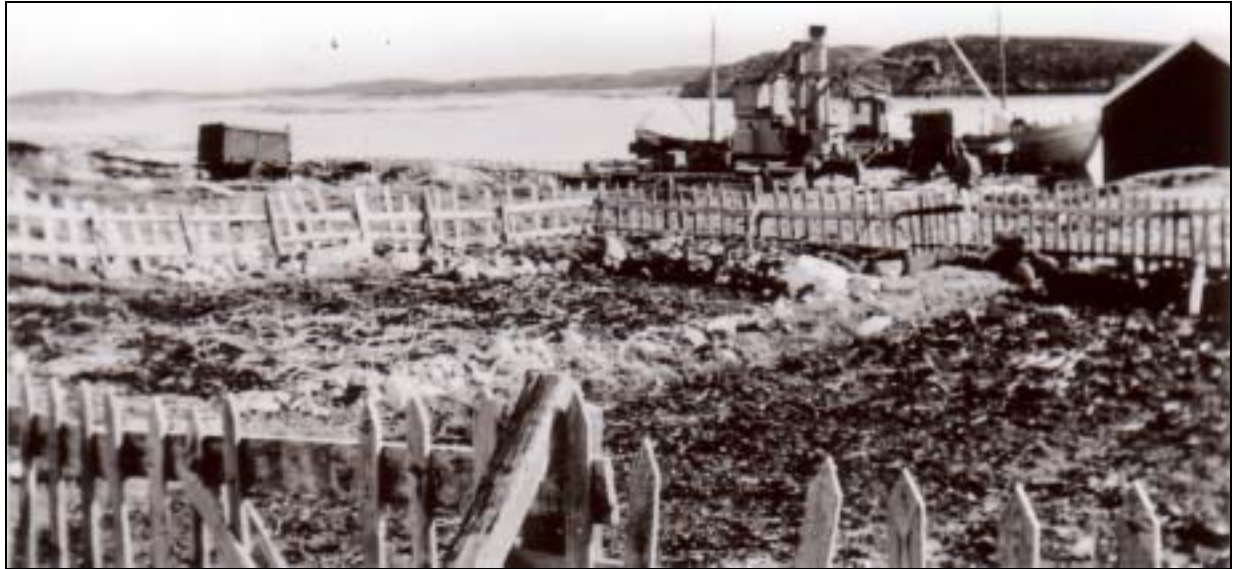
Figur 6. Hegrestein fotografert 1941-43. I forgrunnen sees kjøkkenhagen til fyrvokteren. Den ble ikke brukt av tyskerne. Til venstre sees en dieselmotor-generator for elektrisk kraft. Repro: Fosen bildearkiv.
