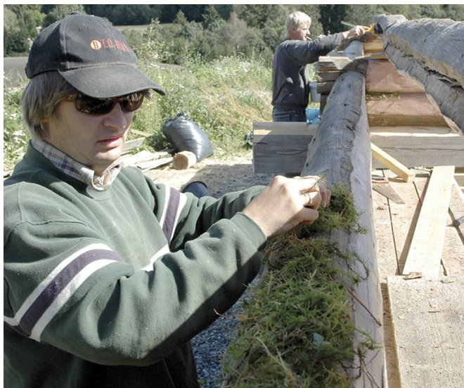
Til isolasjon av tømmerbygninger er det tradisjonelt benyttet mose, som legges mellom tømmerstokkene. I bjelkelagene, eller stubbloftet, ligger det leire. Foto: Kari-Marte Frøyset, Norske Hjem
