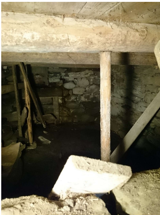
Figur 3 Jordkjelleren med gulvbjelker og steinmur under case-bygget. Bilde: T. Sideridis.
