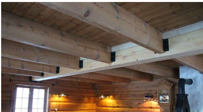
Figur 27 Tannbjelker brukt for bæring av etasjeskiller og festet med bjelkesko. Bilde: Rennebu-Bjelken AS.
