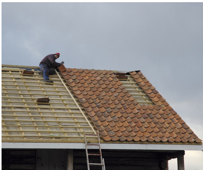
gammel teglstein legges på taket, en lang lekte brukes som siktemål slik at radene blir rette og fine. Foto: Norske Hjem
