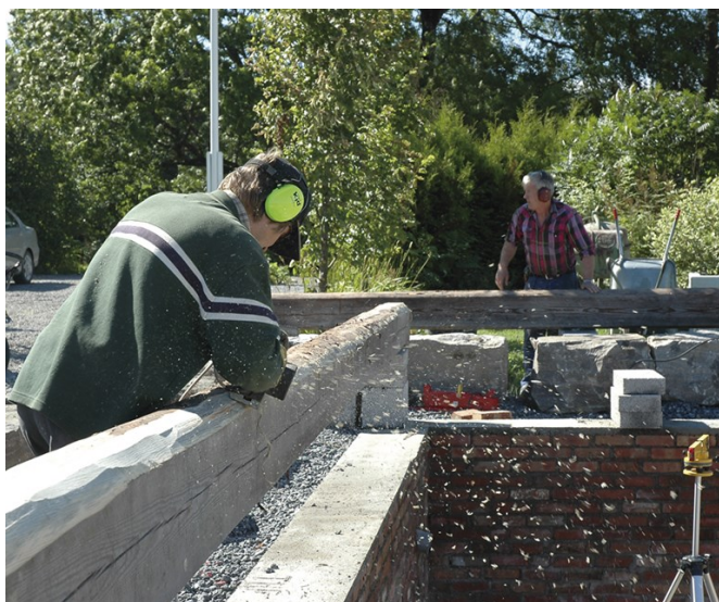
Tor Harald høvler til de nye bunnsvillene. Takk til Tor Harald (bak) som bidro med god veiledning og kunnskap underveis når de nye bunnsvillene skulle lages til. Foto: Norske Hjem
