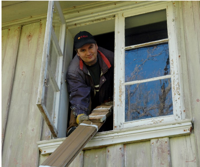
Det er lurt å bunte sammen mindre bygningsdeler som listverk og panel før transport. Foto: Norske Hjem
