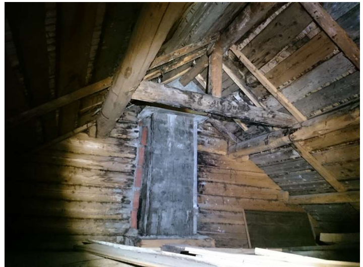
Figur 5 Skader rundt pipa. Bilde: T. Sideridis.
