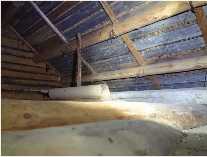
Figur 6 Lektene som er festet til takåsene med kvister. Bilde: T. Sideridis.
