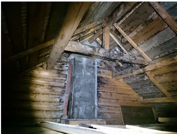
Figur 77 Skadene rundt pipa. (Bilde: T. Sideridis)
