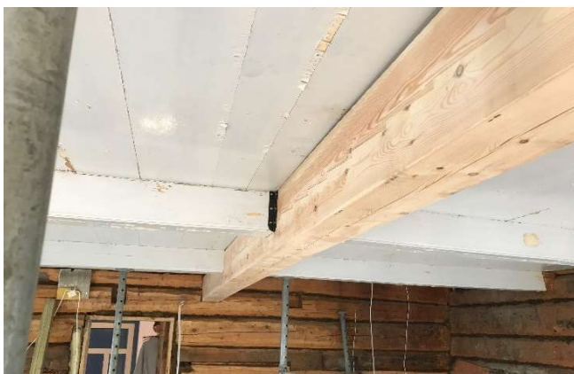
Figur 28 Ny tannbjelke lagt gjennom eksisterende bjelker. Bilde: Rennebu-Bjelken AS.
