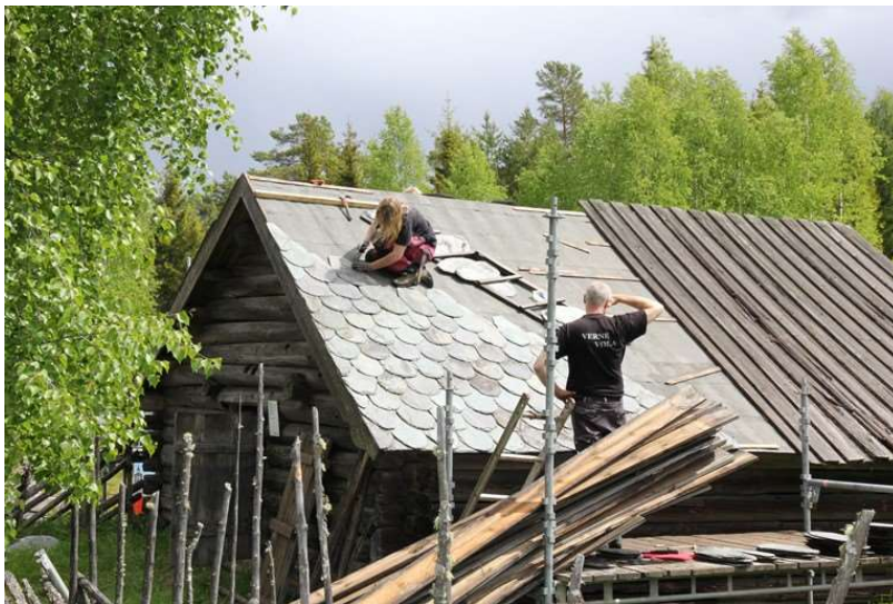
Figur 72 Omlegging av lappskifer på tradisjonelt vis, rett på taktro med belegg. (60)
