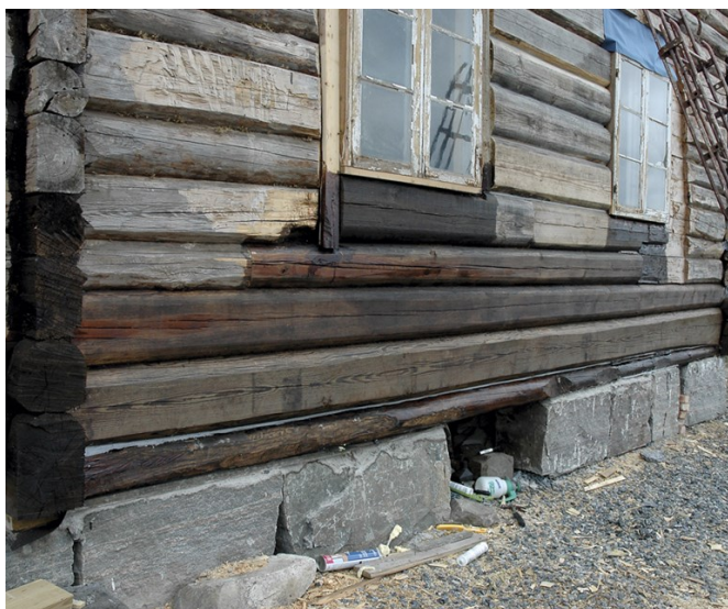
Bunnsvillene og noe av det mest utsatte tømmeret ble behandlet med tjære. Foto: Norske Hjem
