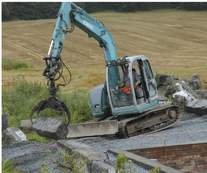
Store grunnmursstein legges på plass med gravemaskin. Foto: Norske Hjem
