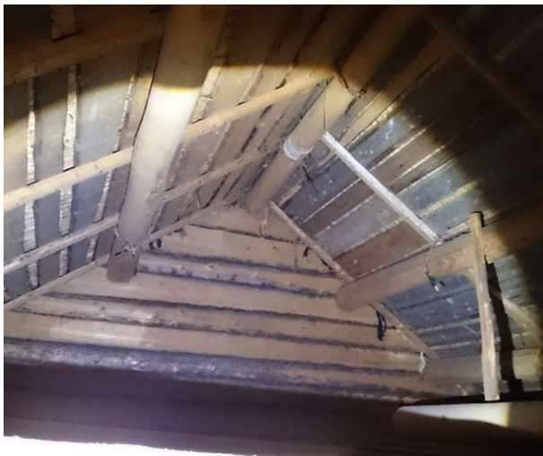
Figur 78 Takåsene fra innsiden av Case-huset. Man kan se oppbygning av undertaket. (Bilde: T. Sideridis)
