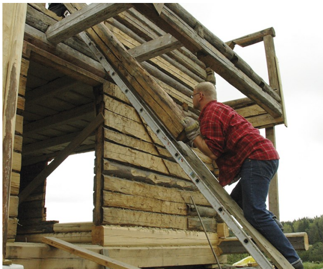
Kraftkaren Kåre Brynjulvsrud skyver her opp en av stokkene til andre etasje, mens jeg, Tor harald Frøyset, drar den opp etter tauet. Ved å legge en planke på stigen på denne måten, klarte vi fint å få opp tunge stokker. Foto: Norske Hjem
