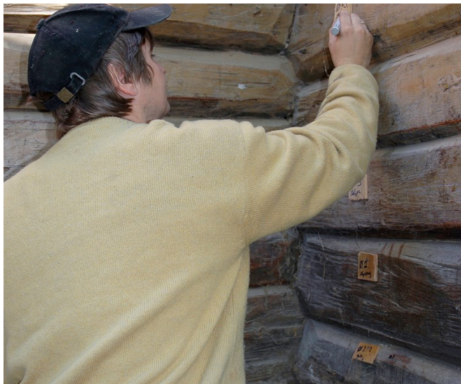
Tømmerveggene i 1. etg. merkes med små finerplater påskrevet med vannfast tusj. Foto: Norske Hjem
