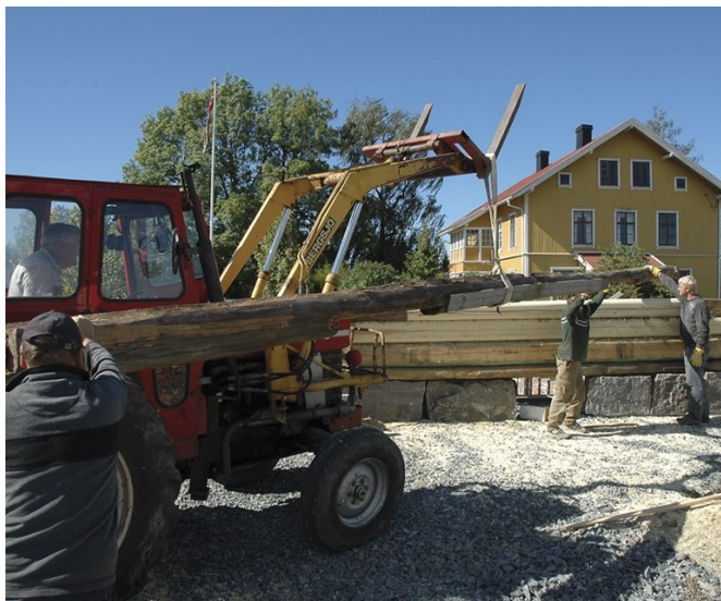
10 meter lang stokk løftes på plass med traktor, så langt det lar seg gjøre. Foto: Norske Hjem
