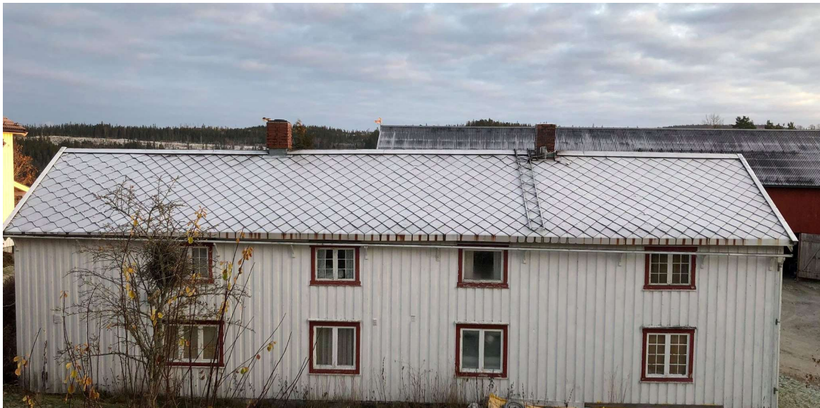
Figur 7 Tydelig forskjell mellom gamle og nye vindu. De gamle vinduene har sprosser og mindre glassruter. Bilde: T. Sideridis.
