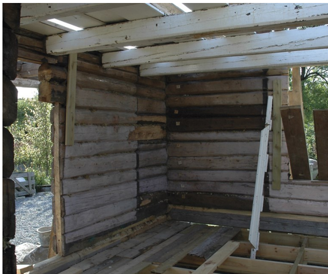
Første etasje er gjenreist. legg merke til sporene etter en gammel skapseng i hjørnet. Foto: Norske Hjem
