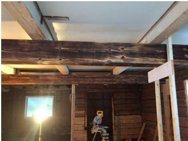
Figur 26 Tannbjelke lagt rett under eksisterende bjelker i etasjeskiller. Bilde: Rennebu-Bjelken AS.
