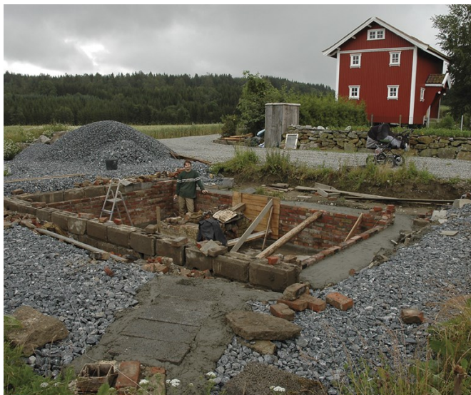
Den gamle kjelleren er antageligvis fra 1912. De gamle teglsteinene og sementsteinen ble brukt om igjen så langt det lot seg gjøre. Foto: Norske Hjem
