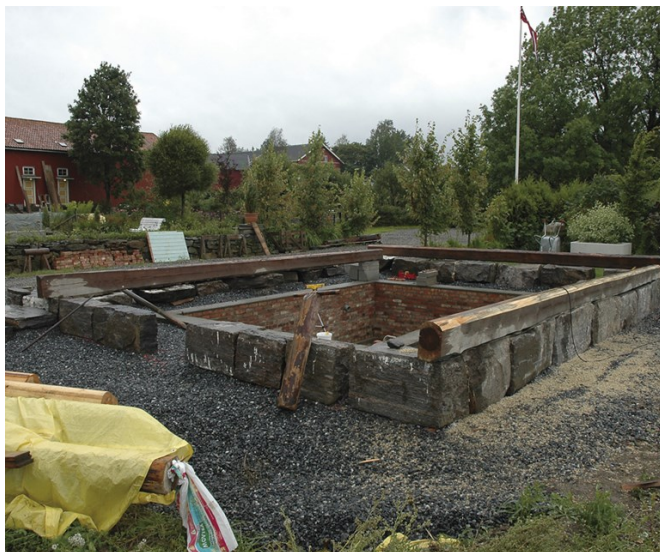
Kjelleren er ferdig og alle grunnmurssteinene er på plass. De første bunnsvillene er i ferd med å tilpasses den nye grunnmuren. Vær oppmerksom på at gamle grunnmurer ikke nødvendigvis er i vater og at du må ta hensyn til dette under gjenoppføringen. Vær nøye med oppmålingen! Foto: Norske Hjem
