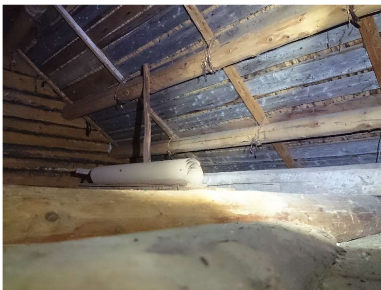
Figur 76 Lektene som er festet til takåsene med kvister. (Bilde: T. Sideridis)
