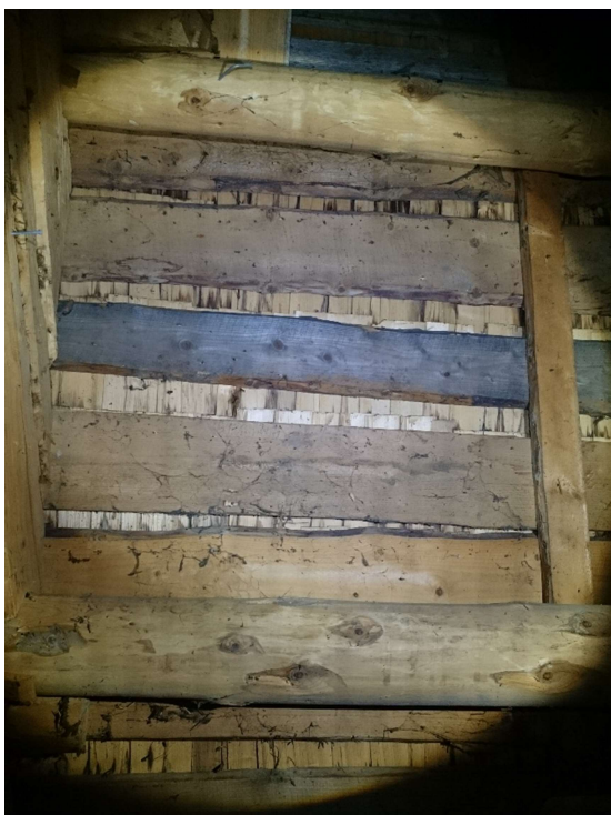
Figur 75 Oppbygning av taket sett innenfra. (Bilde: T. Sideridis)
