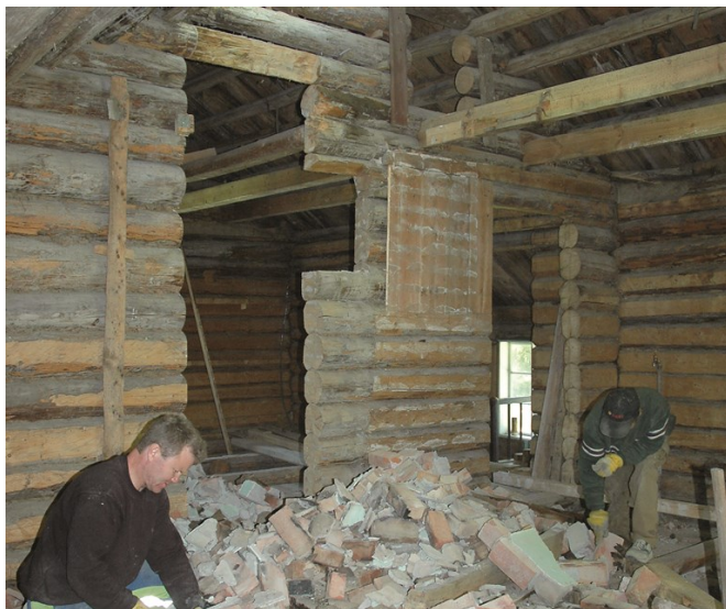
Teglsteinspipa tas ned, all egnet stein renses og brukes om igjen. Her ser vi Jon Erling Mustorp i sving med hammeren en dugnadsdag. Foto: Norske Hjem
