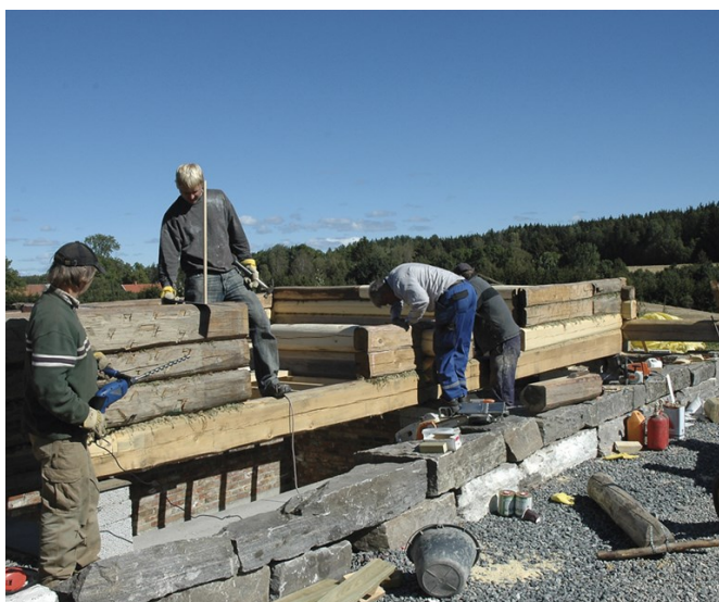
Her er vi godt i gang med å lafte opp de gamle stokkene. Det bores opp hull til treplugger/ dumlinger som hjelper til å holde tømmerveggene stabile. Foto: Norske Hjem
