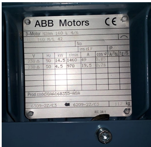
Figur A5.1: Merkeskilt viftemotor tilluftsvifte 360.01
