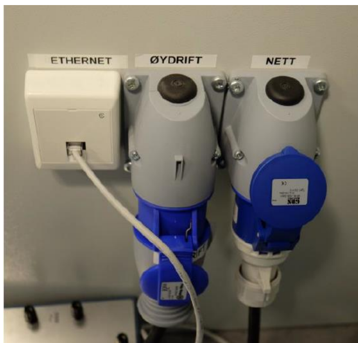
Figur 5 Rundstifter høyreside av kontrollskap
