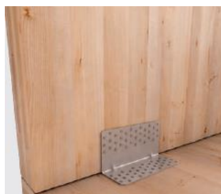
Figur 9: Forankring av et massivtre-veggelement (93)
