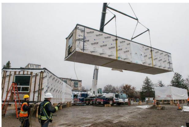
Figur 7: Heising av modul på byggeplass (16)
