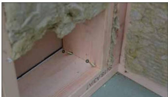
Figur 8: Forankring av stenderverk (92)
