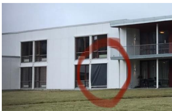
FIGUR 9: SØRVENDT VINDU MED EKSISTERENDE, DELVIS FUNGERENDE SCREEN
