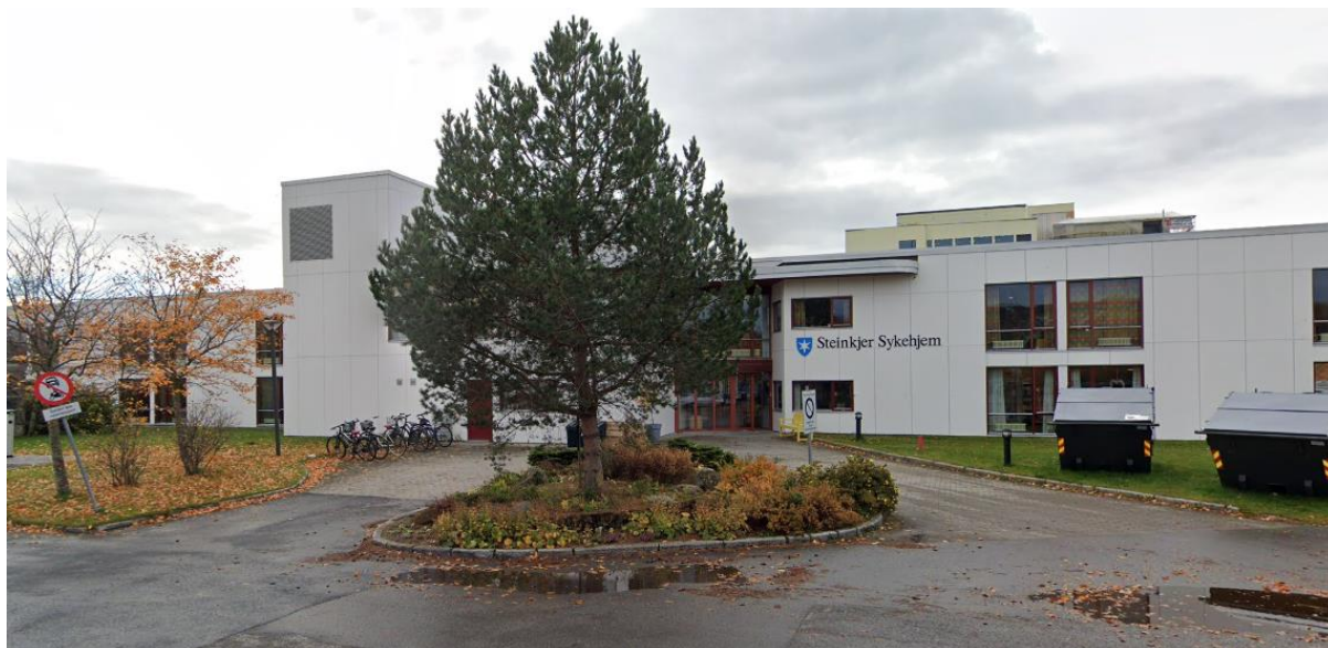
FIGUR 3: STEINKJER SYKEHJEM, HOVEDINNGANG. LUFTINTAK MOT NORDØST, 3. ETG
