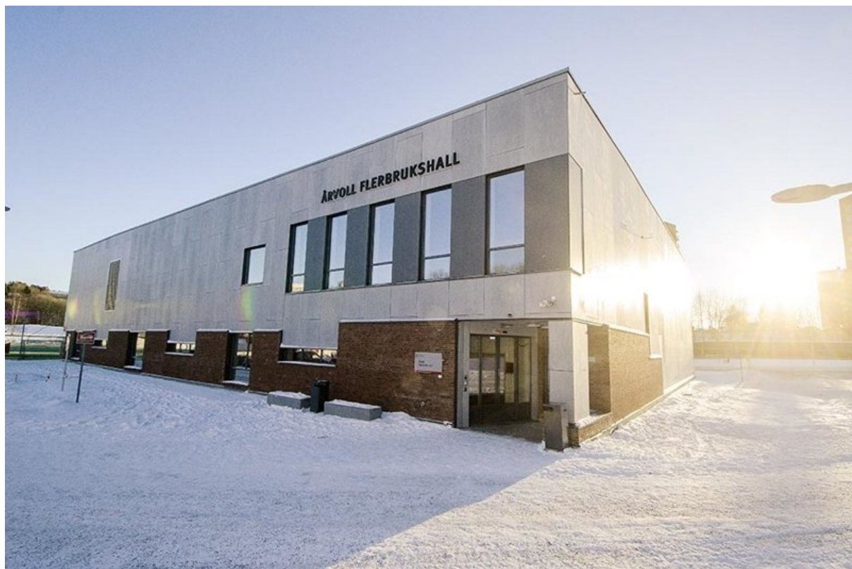
Figur 4.10: Årvoll flerbrukshall. Foto: Sindre Sverdrup Strand, Byggeindustrien
