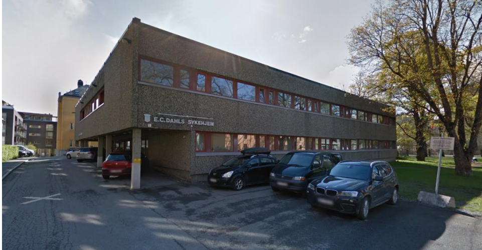
Figur 18: EC Dahls Sykehjem sett fra vestsiden.
