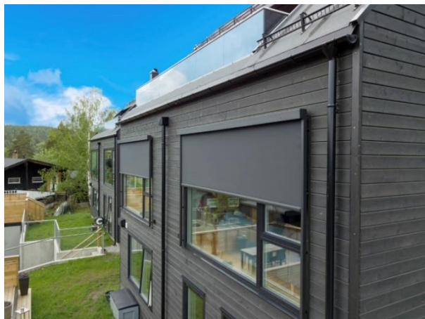
Figur 23:Utvendige sorte screens
