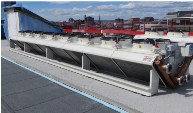
Figur 3: Tørrkjøler, hentet fra Novema Kulde AS (13)
