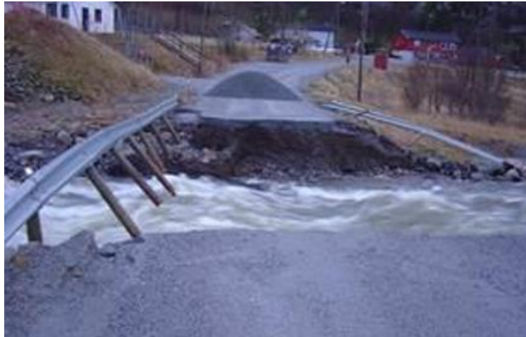
Figur 13: Tette stikkrenner kan få store konsekvenser (figur 8.18 s.113 i Læreboken Drift og vedlikehold av veger)
