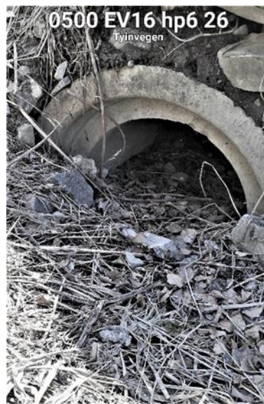
Figur 12: Bilde fra befaring viser innløp som er tettet av kvist og løv (Bilde er tatt av Christine Granum Nygård 20.4.2020)
