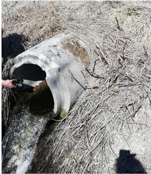
Figur 4: Bilde fra befaring viser skader på rørelement (Bilde er tatt av Christine Granum Nygård 20.4.2020)
