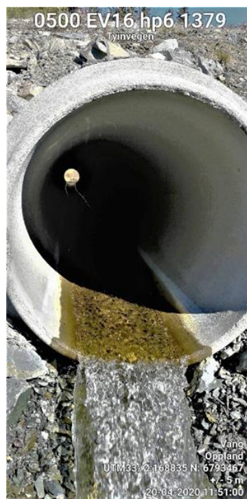
Figur 3: Bildet fra befaringen viser en velfungerende stikkrenne i betong (Bilde er tatt av Christine Granum Nygård 20.4.2020)
