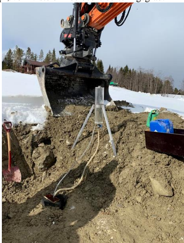
Figur 27: Gravemaskin ble brukt for å fjerne snø og det øverste jorlaget før infiltrasjonstesten.
