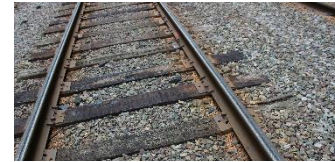
Figur 22: Jernbanespor installert med tresviller
