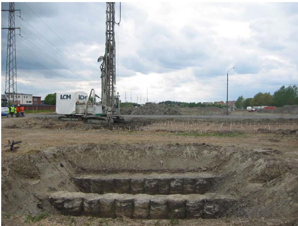
Bilde 3.2b Kalksementrigg som installere kalksementpeler. (Norges Geotekniske Institutt 2011)
