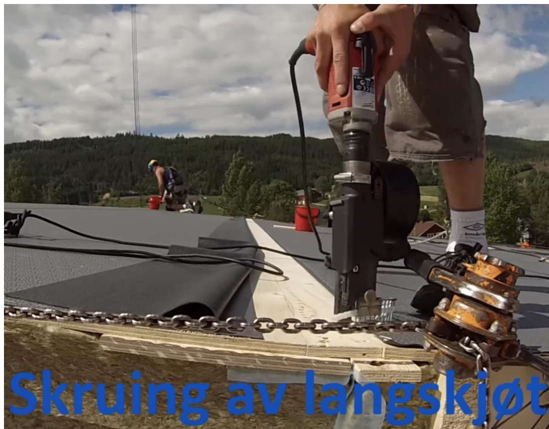
Figur 31 Festing av kryssfinerplater («Lett tak montasjefilm - YouTube», 2013)
