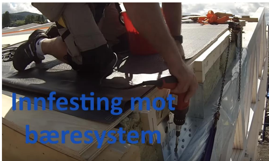
Figur 30 Innfesting mot bæresystem («Lett tak montasjefilm - YouTube», 2013)
