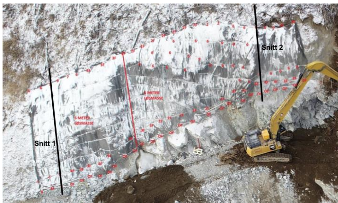
Figur 7: Bilde av skjæring som viser dybde på løsmasser. [12]
