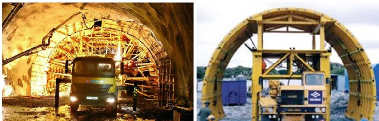
Figur 17: Full utstøping. Støpeskjoldet kan påmonteres på f.eks. dumper. [40]
