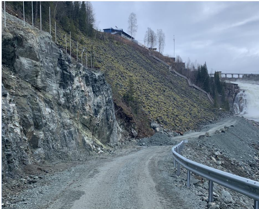
Figur 26: Området for gjennomslag og etablering av forskjæring etter vegskjæring. Foto av Skanska.
