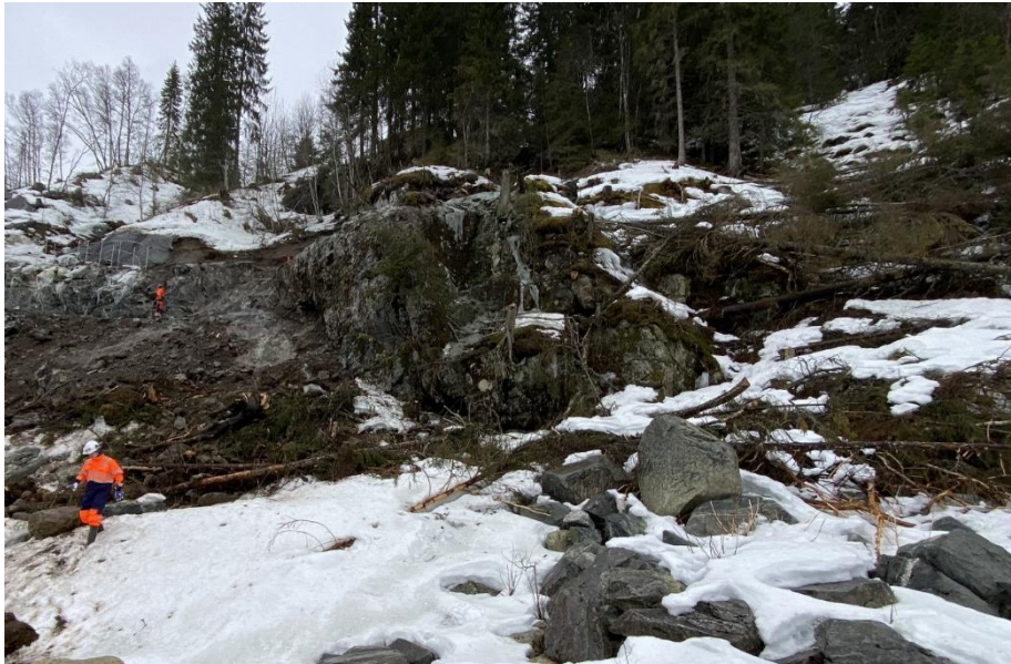
Figur 25: Området for gjennomslag og etablering av forskjæring før vegskjæring. Privat bilde.
