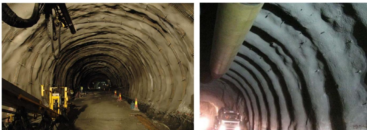
Figur 16: Viser armeringsbuene før og etter spruting. [39]
