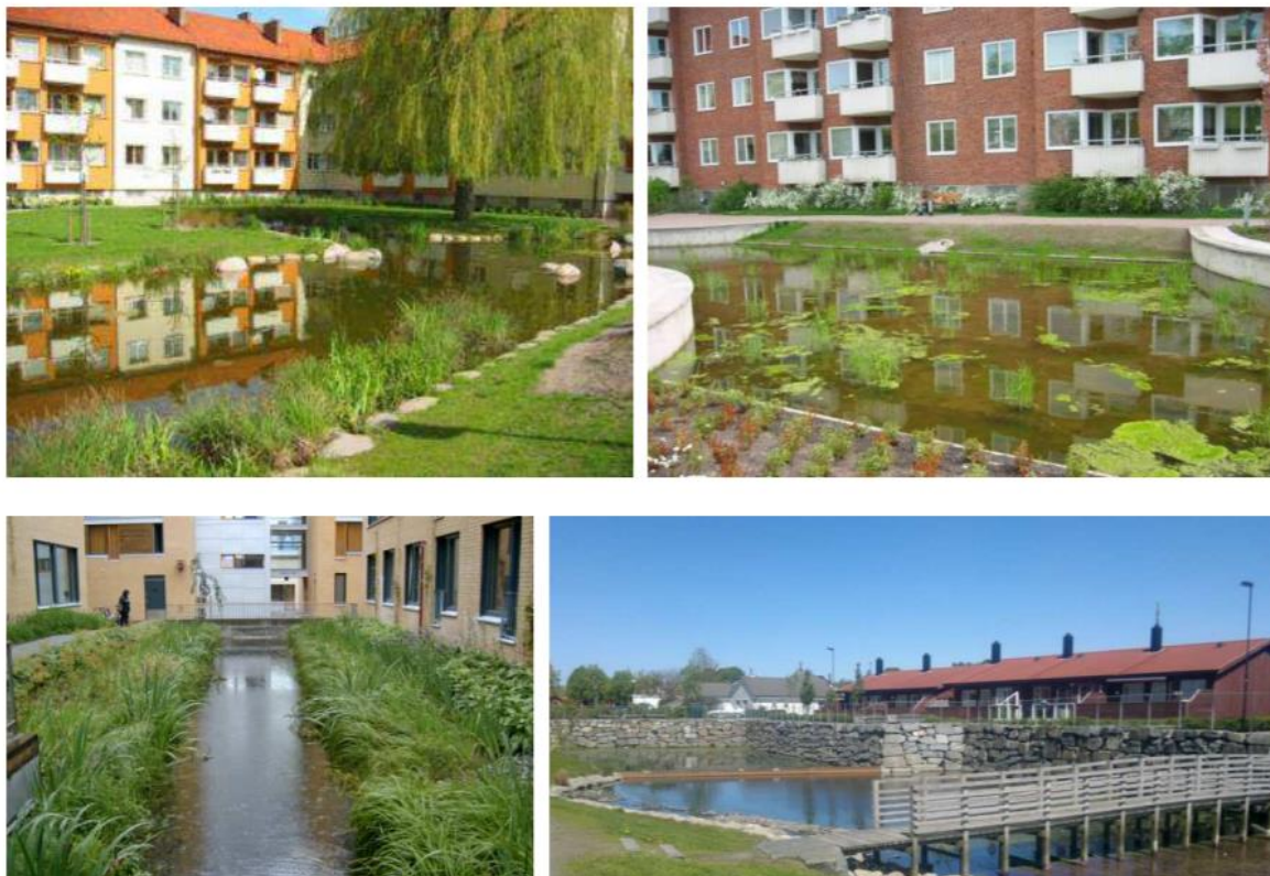
Figur 10 Fordrøyningsdammer i boligbebyggelse (Foto; Frank Bjørnø)
