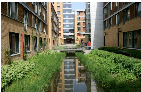
Figur 14 Overvannskanal, Bjølsen studentby (Foto: Dronninga landskap)
