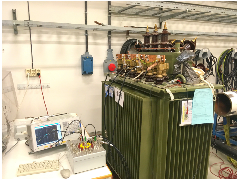
Figur 7.1: Frekvenssveipmålinger på 11/0.23 kV transformator med isolerte nullpunkt.
