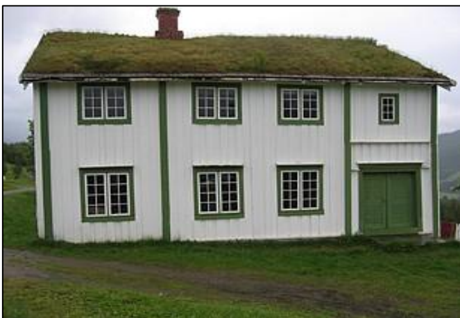
Figur 4.2: Bjørgan prestegård (Statsbygg 2012)
