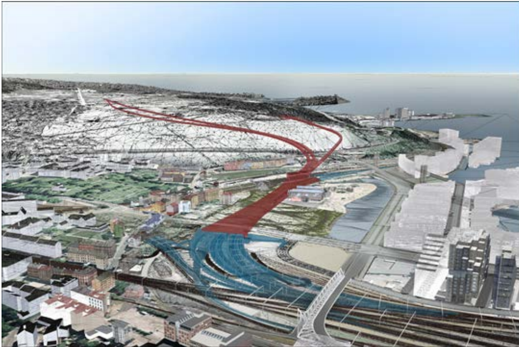
Figur 7: Follobanen – Oversiktsbilde/illustrasjon fra Oslo S mot Ekebergåsen. Kilde: Bane NOR/ViaNova. Den nye Follobanen med dobbeltspor mellom Oslo og Ski er 22 km lang, og prosjektet er Norges hittil største samferdselsprosjekt. Jernbanetunnelen er drevet med TBM. Tunnelarbeidet startet i 2015 og var ferdig i 2019 og omfattet ca. 5.6 mill. m 3 tunnelmasse.
