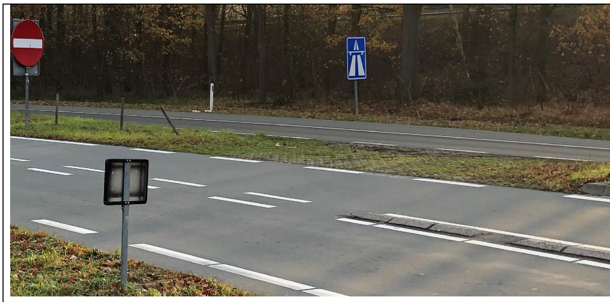
Figur 58: På- og avkjøringsrampe fra motorveg A67. Avslutning av kantstein i midtrabatt, stiplet oppmerking og steinsetting gjør arealet overkjørbart. FOTO: Kjell-Amund Prestmo
