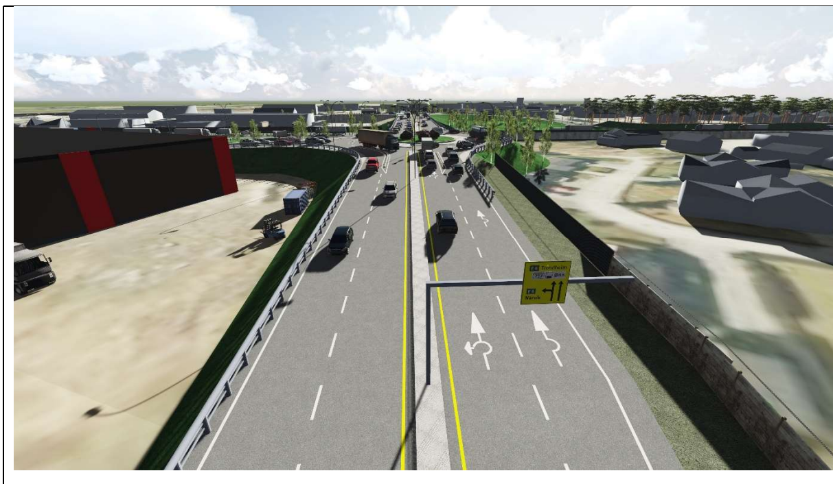
Figur 12: Turborundkjøring øst, arm til/fra sentrum. Forslag til mulig utforming, skilting og oppmerking.
