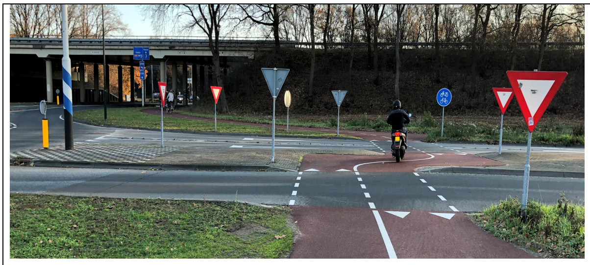
Figur 50: I ytterkant av turborundkjøring er det lagt opp til sykkelveg. Mopedister henvises også hit. Det er ikke lagt opp til løsning for gående i rundkjøring. FOTO: Kjell-Amund Prestmo
