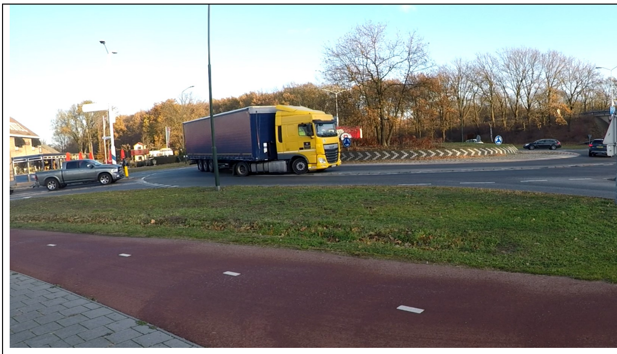
Figur 53: Eksempel hvor vogntog har valgt feil felt på tur inn i rundkjøringen. Velger derfor å ta seg over rundkjøringas overkjørbare areal, for å komme seg ut på Motorveg A67. FOTO: Kjell-Amund Prestmo
