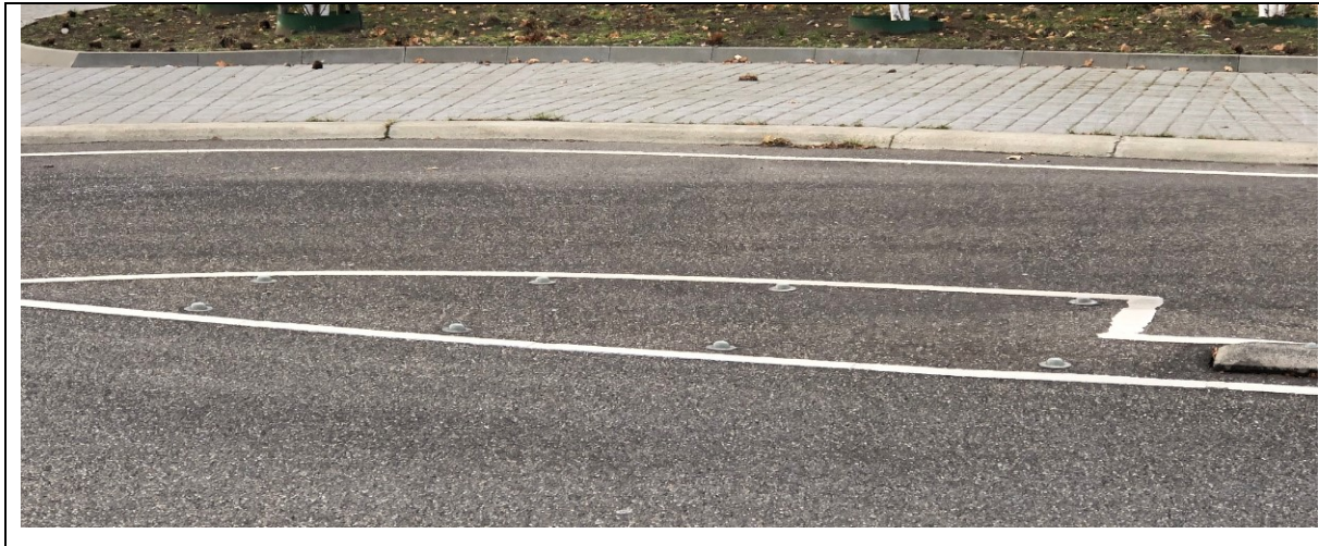
Figur 60: Observert alternativ utforming av dråpe ved start av separasjonsareal mellom kjørefelt i selve rundkjøringa. Her med kun oppmerking og refleksjonsdioder. Fra turborundkjøring langs veg Collse Hoedfdijk nord for Geldrop, mellom hovedveg A67 og A270. Foto: Kjell-Amund Prestmo
