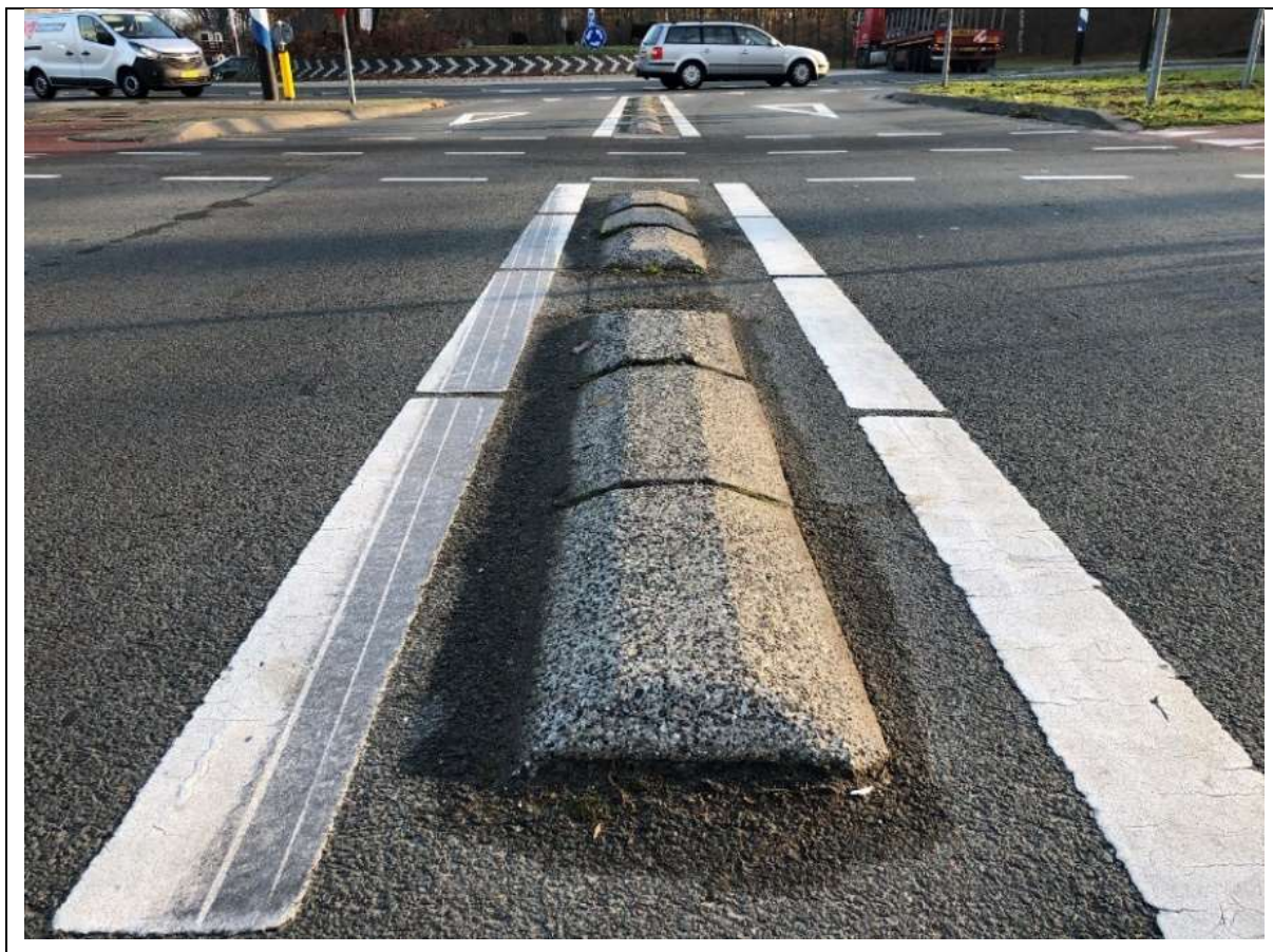
Figur 55: Standard trafikkskille mellom kjørefelt inn mot, og i turborundkjøring. Foto av Kjell-Amund Prestmo
