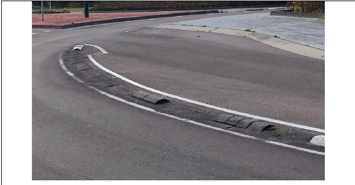
Figur 56: Trafikkskille og refleksjonsdioder i turborundkjøring er delvis borte, trolig som følge av «påkjøringssslitasje». Foto av Kjell-Amund Prestmo
