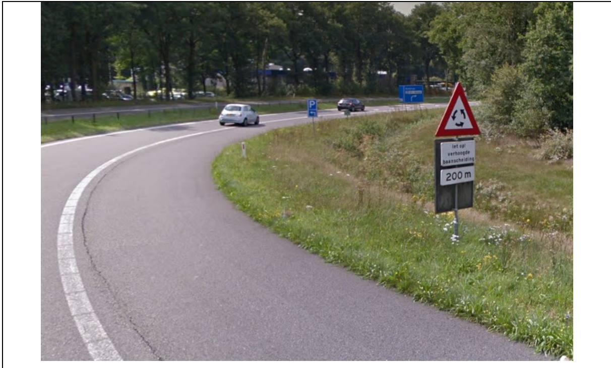
Figur 65: Geldrop - Rampe fra motorvei inn mot turborundkjøring i sør. veivisningskilt erstattet med fareskilt rundkjøring. FIGURKILDE: Google Maps
