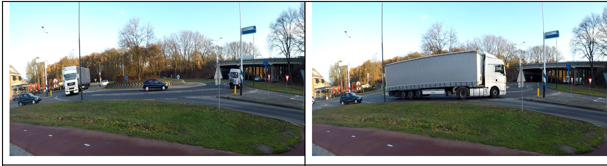
Figur 52: Eksempel hvor semitrailer kjører over rundkjøringas overkjørbare areal og trafikkskille mellom kjørefeltene. FOTO: Kjell-Amund Prestmo
