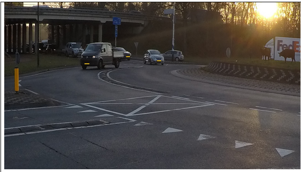
Figur 72: Geldrop – Nederland. Kryss i ytre sirkulasjonsfelt oppmerket med linjetype sperrefelt. FOTO: Kjell-Amund Prestmo
