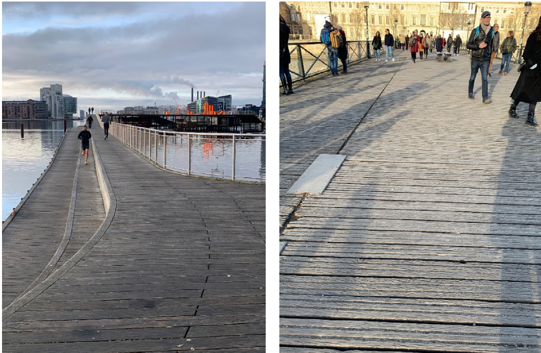
Figur 8.3. Eksempler på treverk brukt til gangbane, begge med tverrgående bord. Til venstre i København, til høyre gangbro i Paris. Freste spor i dekket ivaretar sklisikkerhet. Ytveden er slitt bort med tiden slik at bare kjerneveden gjenstår, noe som øker sklisikkerheten ytterligere.
