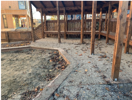
Sand og treplattning av terrassebord med riller
