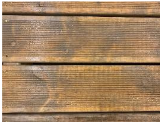
Figur 7.4: Impregnert treverk med riller, nærbilde
