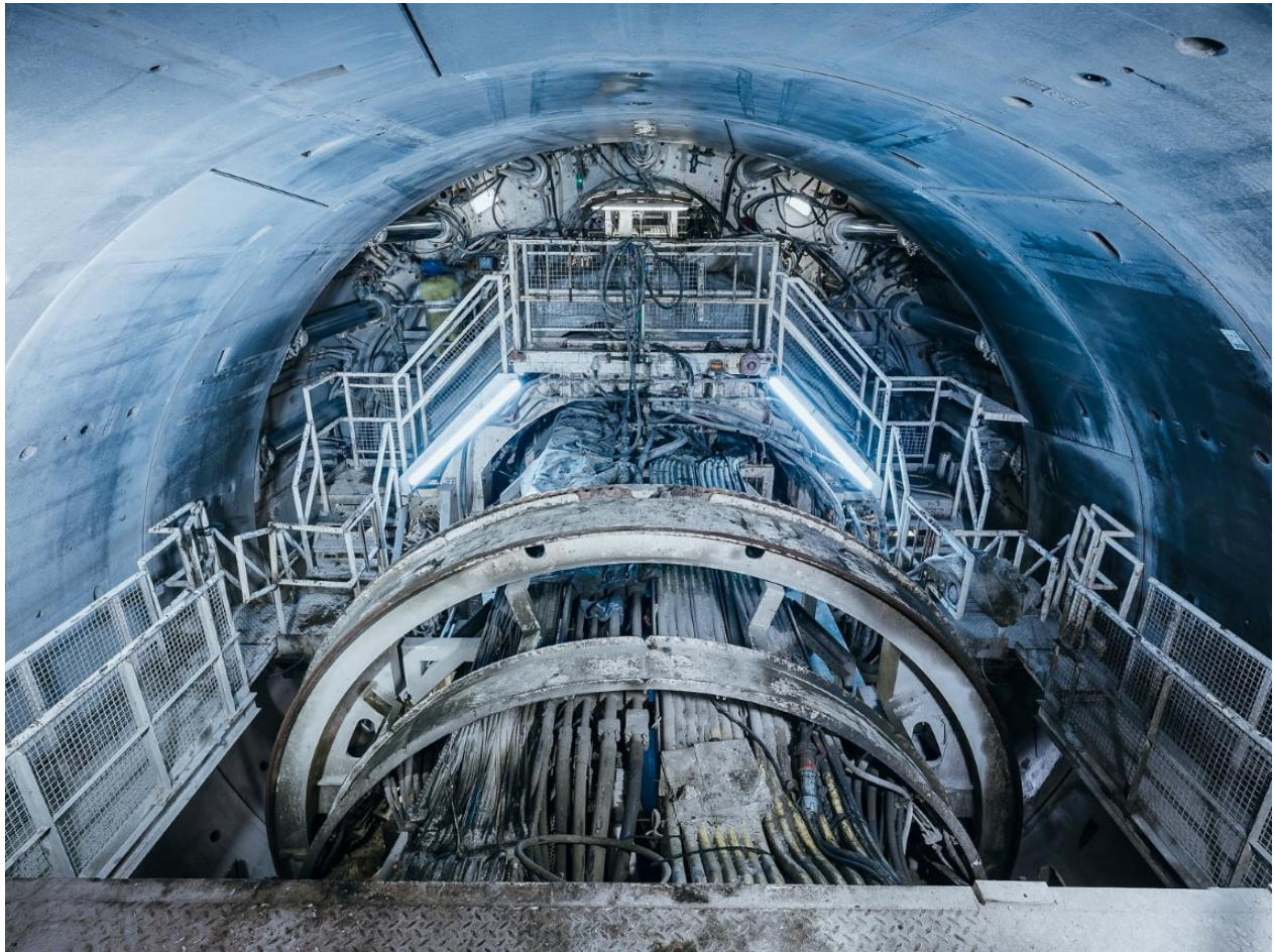
Figur 25: Tunnelens overfalte i Follobanen etter montering av betongsegmenter bak maskinen (hentet fra Bane Nor (2018))
