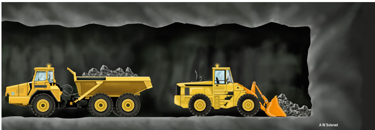
Figur 10: Sprengte masser lastes på dumper som kjører massene ut av tunnelen. Hentet fra Statens Vegvesen (2012b)
