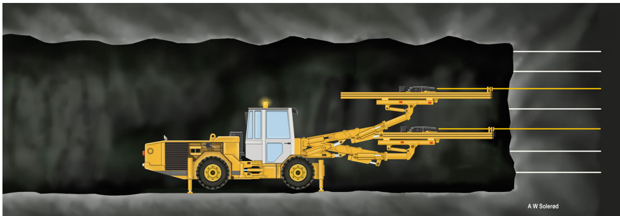
Figur 8: Boring av borhull før lading med sprengstoff. Hentet fra Statens Vegvesen (2012b)
