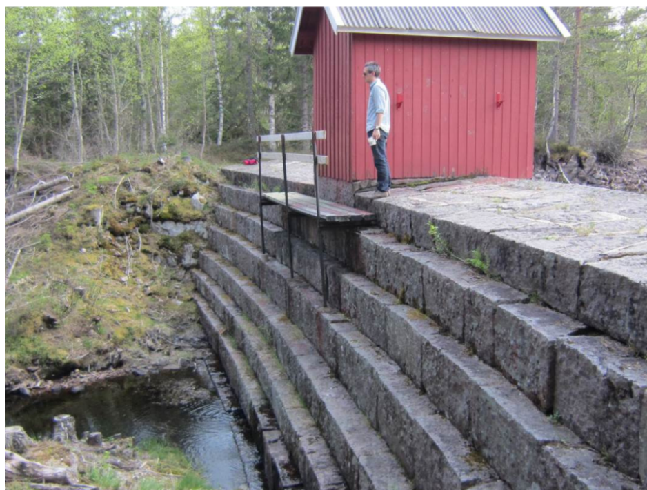
Figur 2.1: Dam Solbergvann, tørrmurt dam bygget i 1903, bruddkonsekvensklasse 3 [13].
