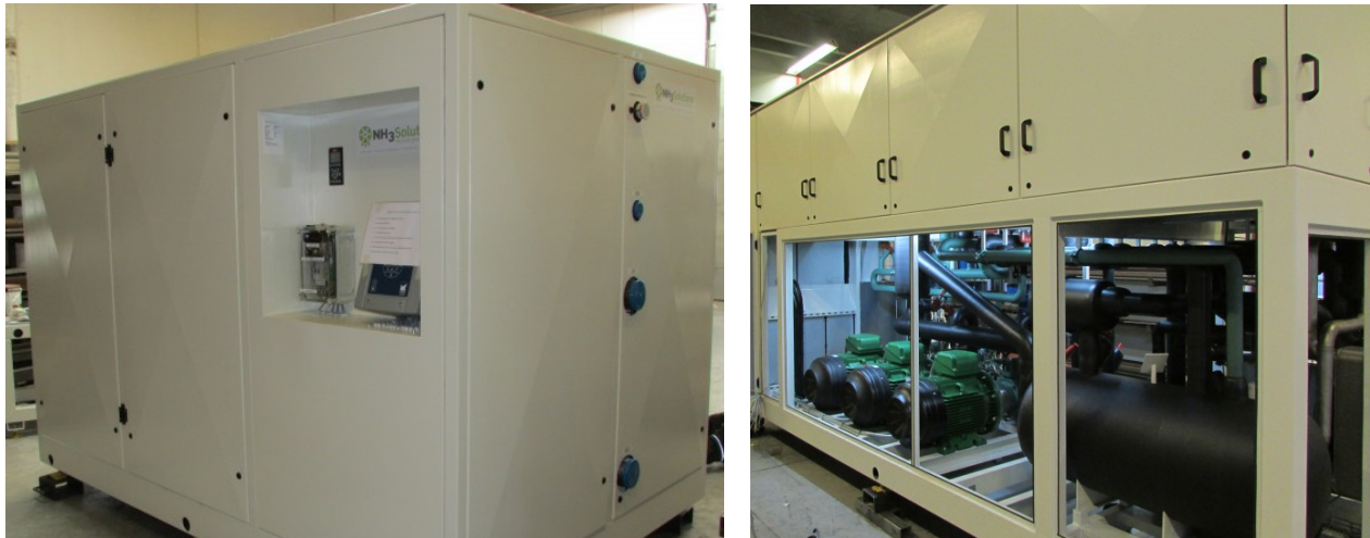
Figur 8.2: Rom-i-rom ammoniakk-varmepumpe (NH 3 Solutions, 2019) Leveres som spesialtilpassede varmepumper fra 50 kW og opp.
