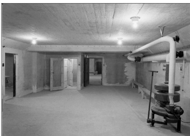
Figur 15 Bilde av bomberommet tatt av Schrøder i juni 1940 med en tysk ventilator installert. Fotograferingen nevnes i Engers dagsrapport. Foto hentet fra: https://digitaltmuseum.no/011012896462/rode-kors-forstehjelpsstasjon-i-tinghuset
