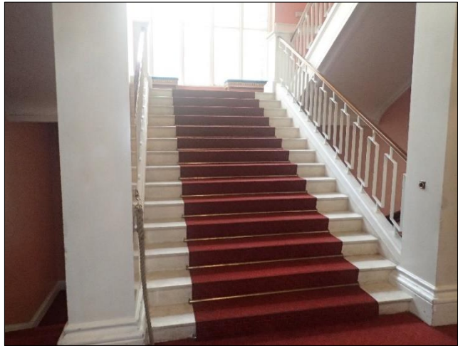
Figur 31 Trappen opp til 3. etasje. Foto: Andreas Alsaker.
