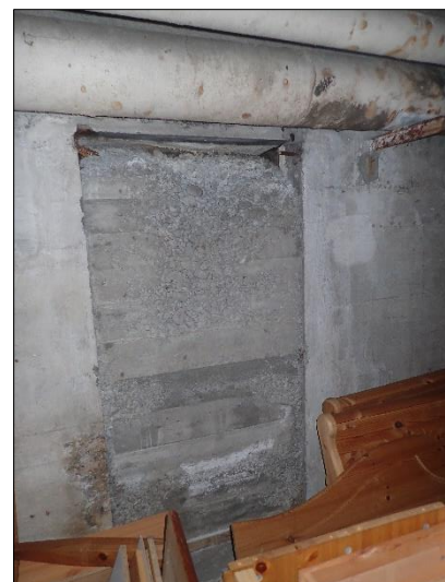
Figur 16 Den gjenmurte gangen til garasjen Foto: Andreas Alsaker
